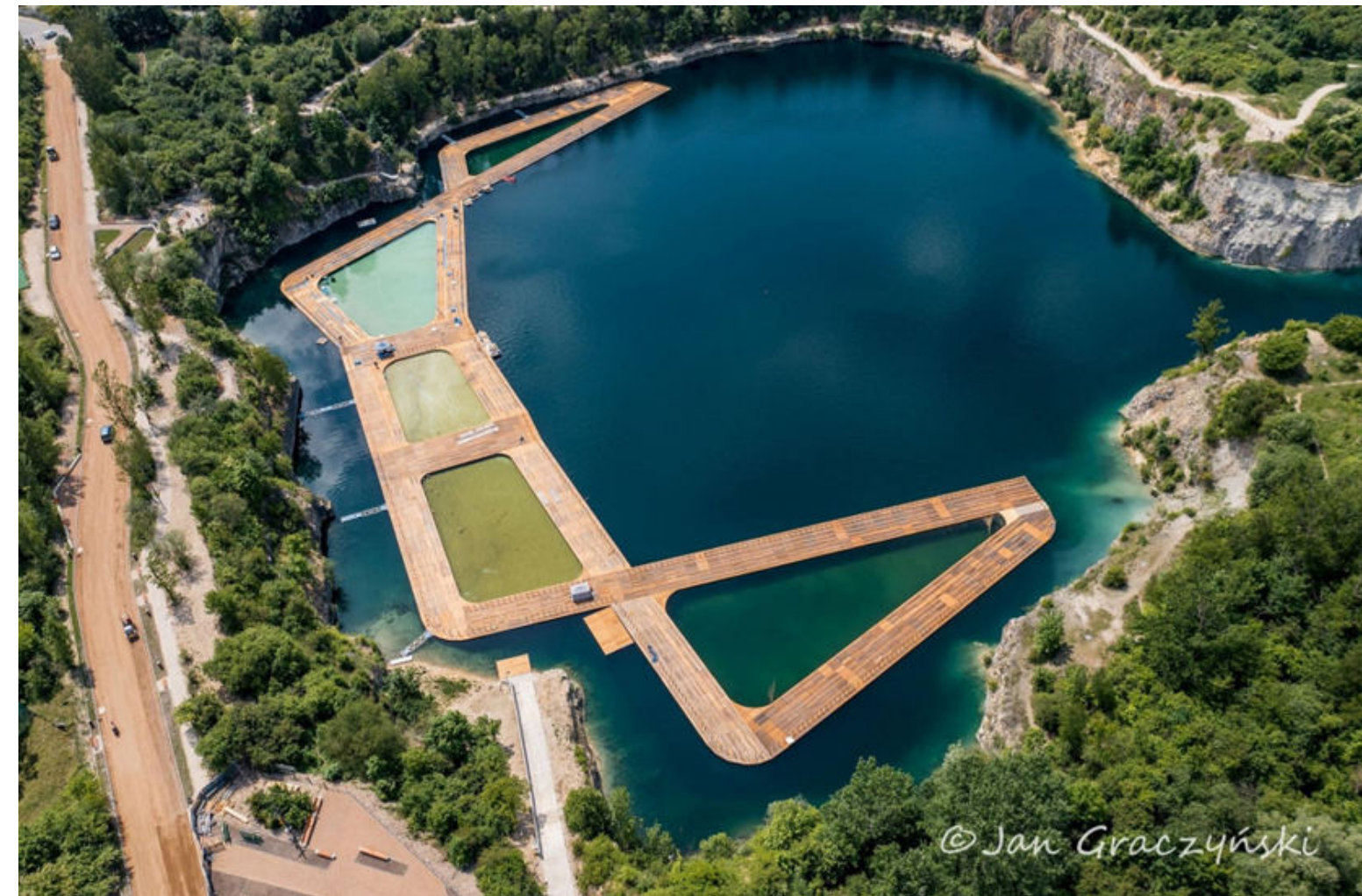
Затоплена каменоломня «Zakrzówek», Республіка Польща
