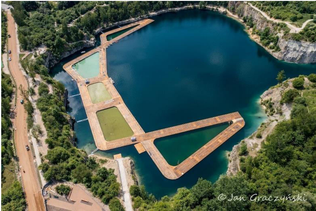
Рисунок 1.5 – Затоплена каменоломня «Zakrzówek», Республіка Польща
