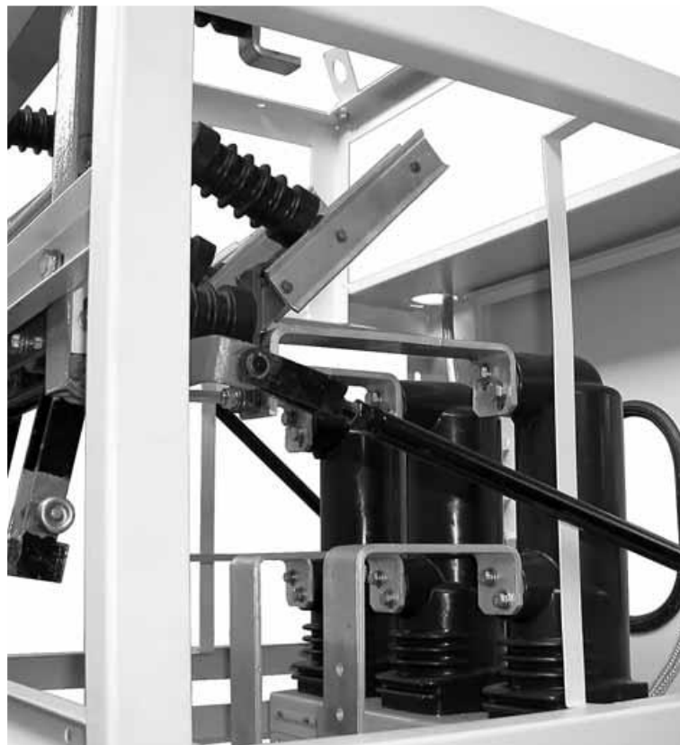
Рисунок 9.2 - Комплект монтажних частин з вимикачем ВР1, встановлений в КСО
