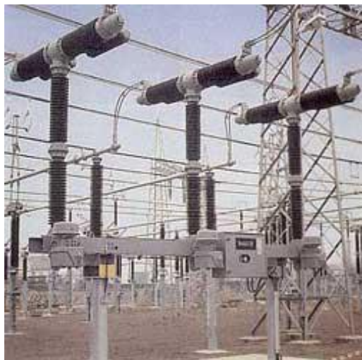
Рисунок 9.4 - Загальний вигляд вимикача ЗАР2 напругою 420кВ
