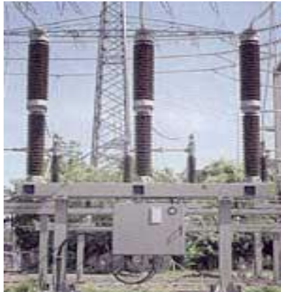
Рисунок 9.3 - Загальний вигляд вимикача ЗАР1 напругою 145кВ
