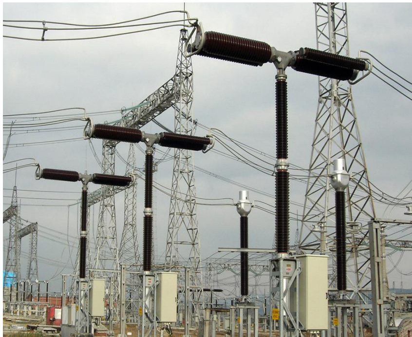
Рисунок 9.1 — Колонковий елегазовий вимикач серії HPL
