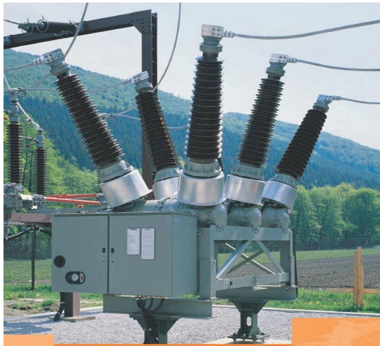
Рисунок 9.2 - Вимикач елегазовий баковий ЗАР1 ДТ
