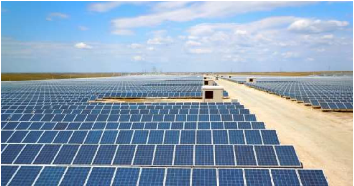
Рисунок 1.2 – СЕС на основі фотобатареї
