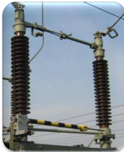
Рисунок 3.7 – Зовнішній вигляд роз'єднувача
