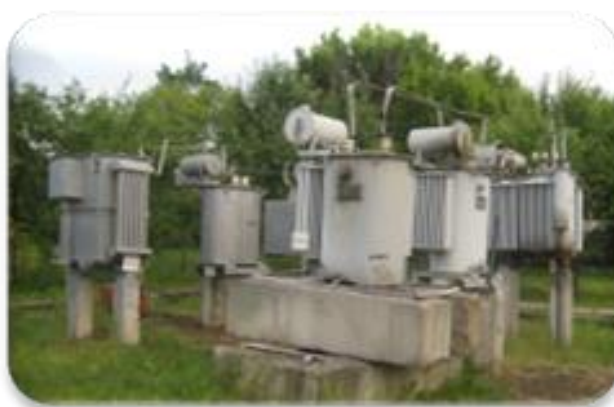
Рисунок 3.13 – Дугогасний реактор
