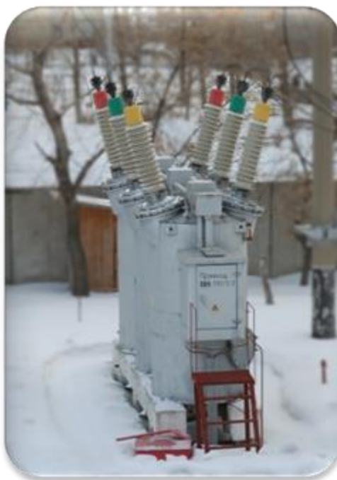
Рисунок 3.5 – Масляний вимикач
