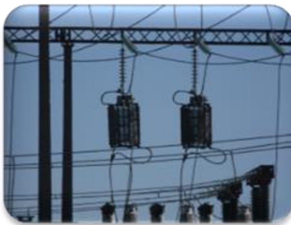
Рисунок 3.14 – Струмообмежувальний реактор
