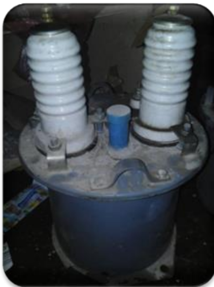
Рисунок 3.11 – Трансформатор напруги
