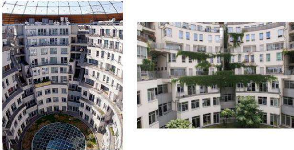
Рисунок 1.6 - Вигляд внутрішньої частини споруди «С» після реконструкції
