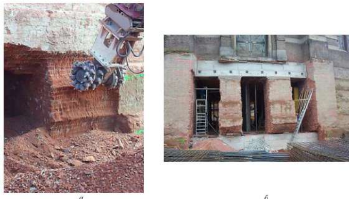
Рисунок 1.9 – Розбирання цегляних стін при влаштуванні дверей і вікон
