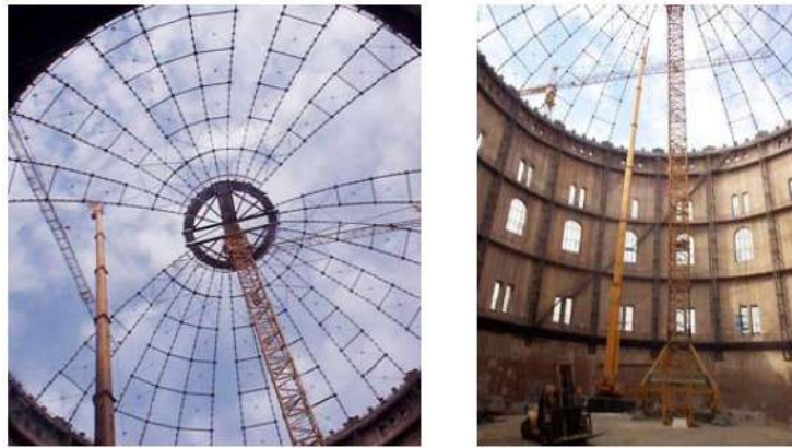
Рисунок 1.8 - Демонтаж конструкцій покриття за допомогою тимчасової опори
