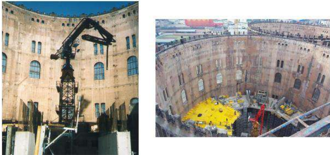
Рисунок 1.10 Бетонування конструкцій стін та перекриттів
