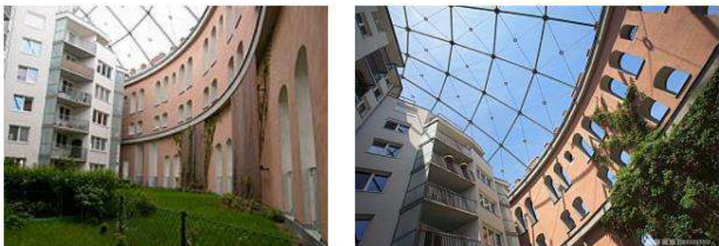
Рисунок 1.7 - Внутрішній вигляд споруди «Д»
