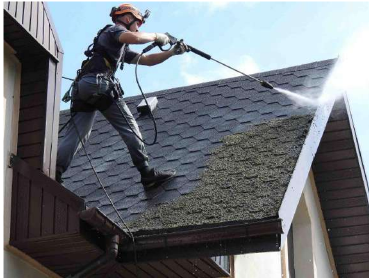
Рисунок 4.8 – Видалення моху та бруду з поверхні даху за допомогою мийки
