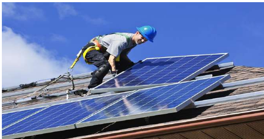
Рисунок 4.18 – Монтаж сонячних панелей
