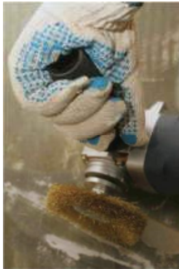
Рис. 4.1 – Усунення відшарувань на укосах за допомогою електрошліфувальної машини
