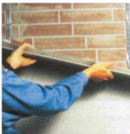
Рис. 4.2 – Розрівнювання правилом нанесеної штукатурної суміші
