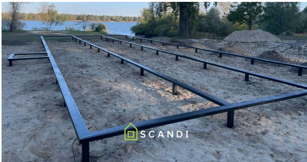
Рисунок 8. Металевий фундамент модульного будинку SCANDI
