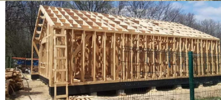
Рисунок 2 – Проект каркасно-щитового житлового будинку
