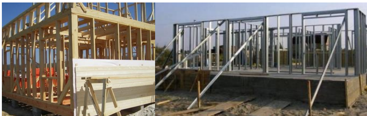
Рисунок 1.7 – Дерев'яний і металевий каркаси каркасно-рамних будинків
