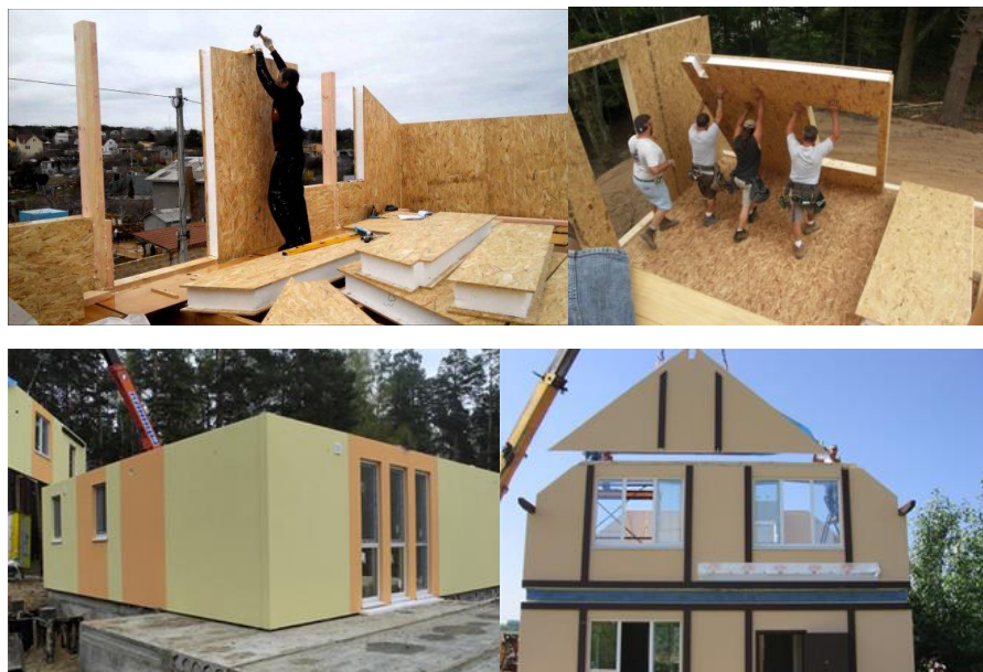
Рисунок 1.6 – Монтаж житлового будинку із СІП-панелей
