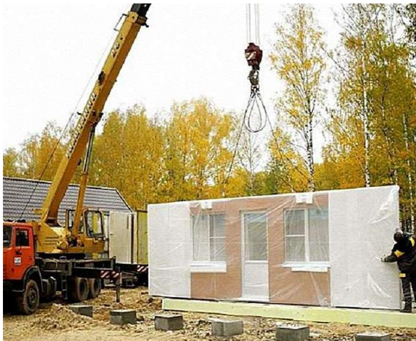
Рисунок 1.2 – Монтаж каркасно-панельного будинку
