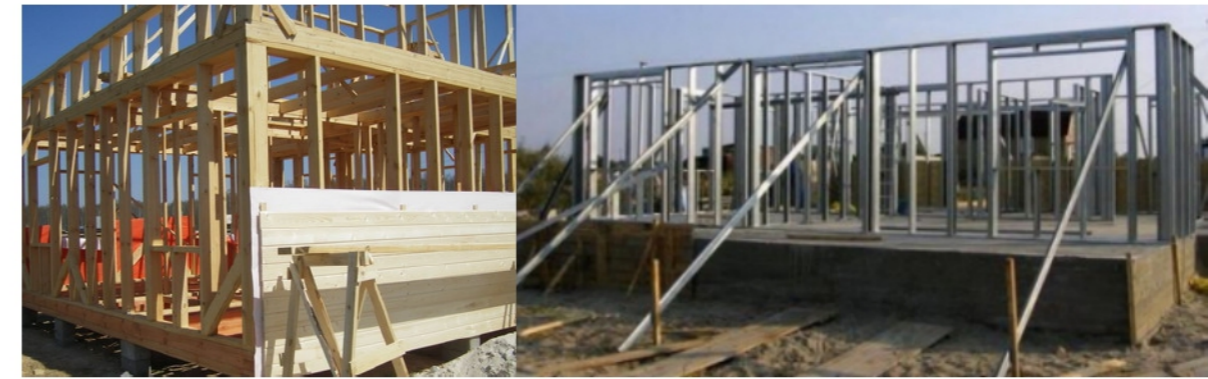
Рисунок 5 – Дерев'яний і металевий каркасно-рамні будинки
