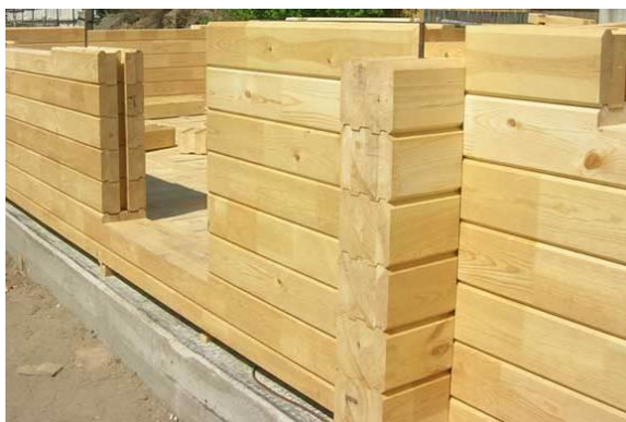
Рисунок 1.10 – Зведення будинку із клеєного бруса
