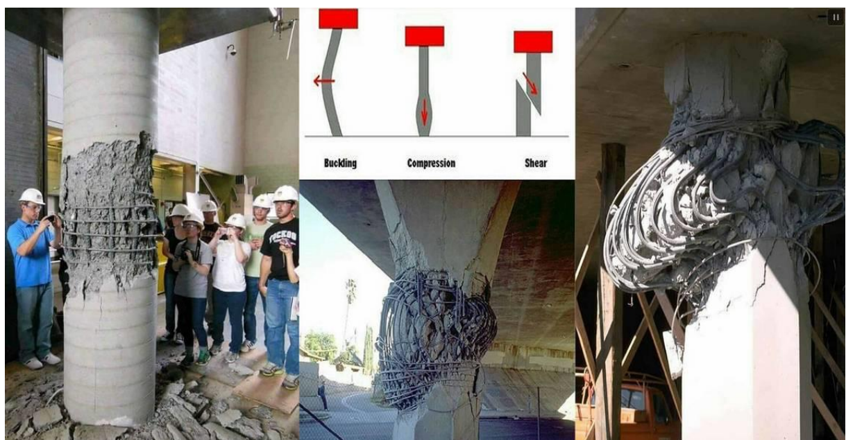
Рисунок 1.3 - Механізм обвалення колон при спільній дії горизонтальних сейсмічних та вертикальних навантажень
