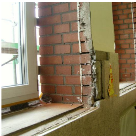
Рисунок 24 – Якість виконання робіт при монтажі віконних рам та кріпленні зовнішніх утеплюючих матеріалів
