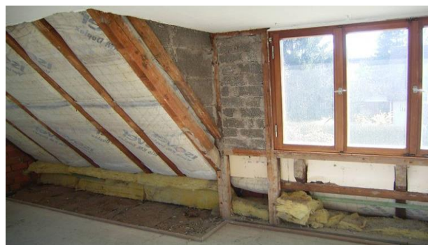
Рисунок 25 – Якість виконання робіт при монтажі утеплюючих матеріалів дахової покрівлі
