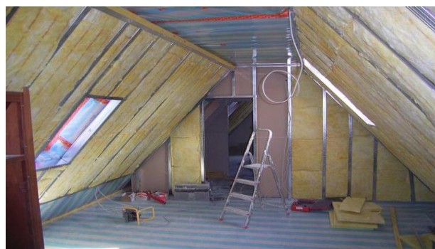
Рисунок 26 – Якість виконання робіт після завершення монтажу утеплюючих матеріалів мансардного поверху
