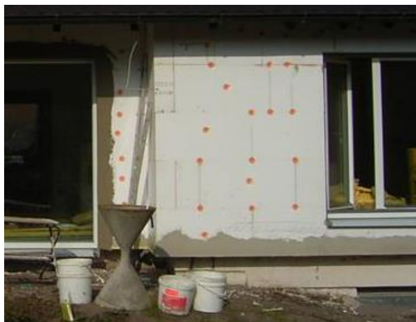
Рисунок 24 – Якість виконання робіт при монтажі віконних рам та кріпленні зовнішніх утеплюючих матеріалів
