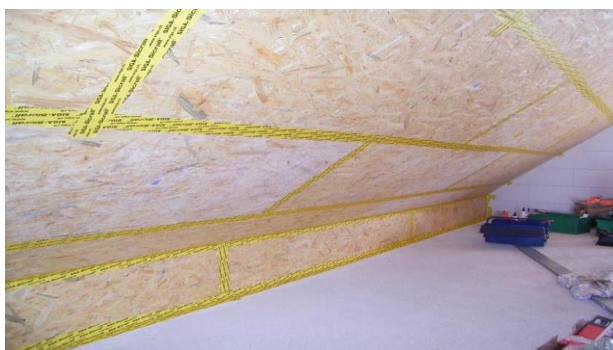
Рисунок 26 – Якість виконання робіт після завершення монтажу утеплюючих матеріалів мансардного поверху
