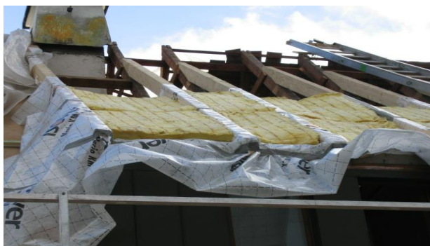
Рисунок 25 – Якість виконання робіт при монтажі утеплюючих матеріалів дахової покрівлі
