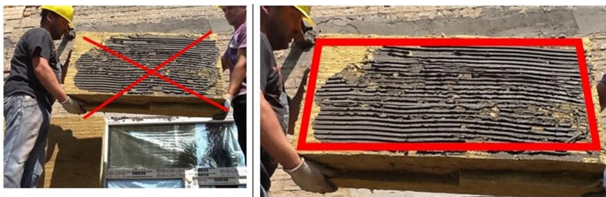
Рисунок 23 – Якість виконання робіт при утепленні зовнішніх фасадних частин стінової огорожі
