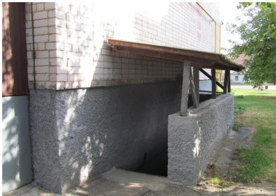
Рисунок 34 - Вхід до підвалу
