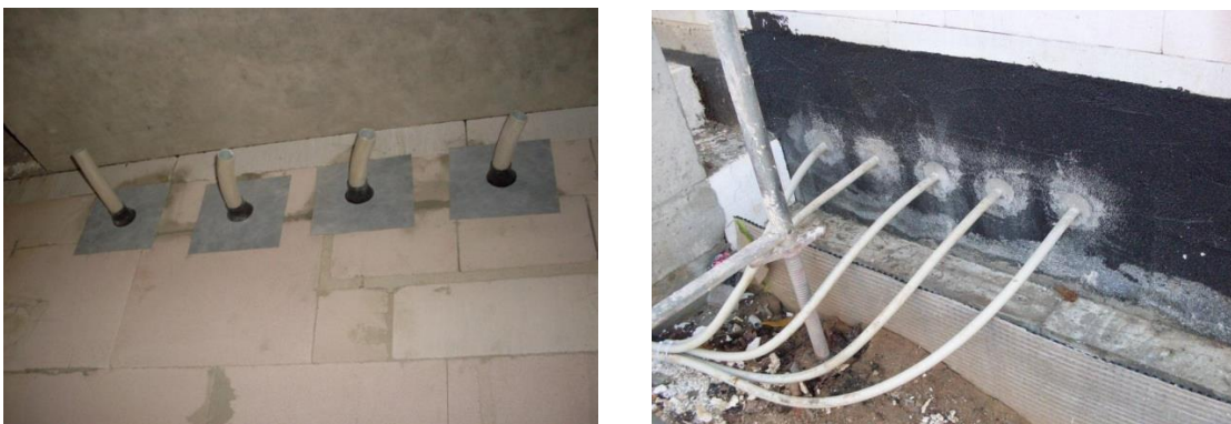
Рисунок 27 – Якість виконання робіт після завершення монтажу утеплюючих та досягнутий рівень герметичності
