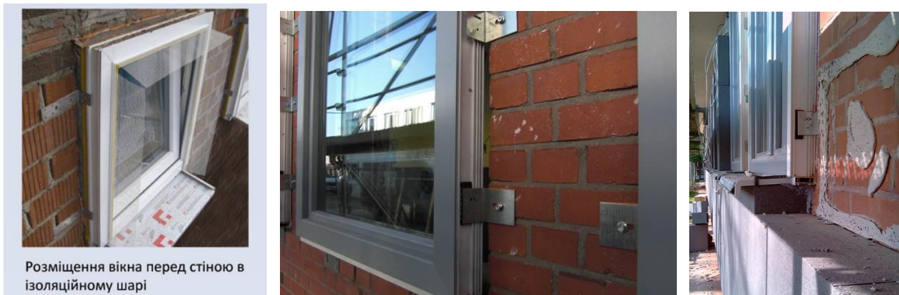
Рисунок 21 - Технічні рішення з монтажу вікон
