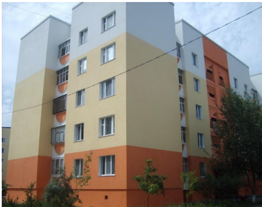
Рисунок 1.1 - Фасадна система типу «мокрый фасад»
