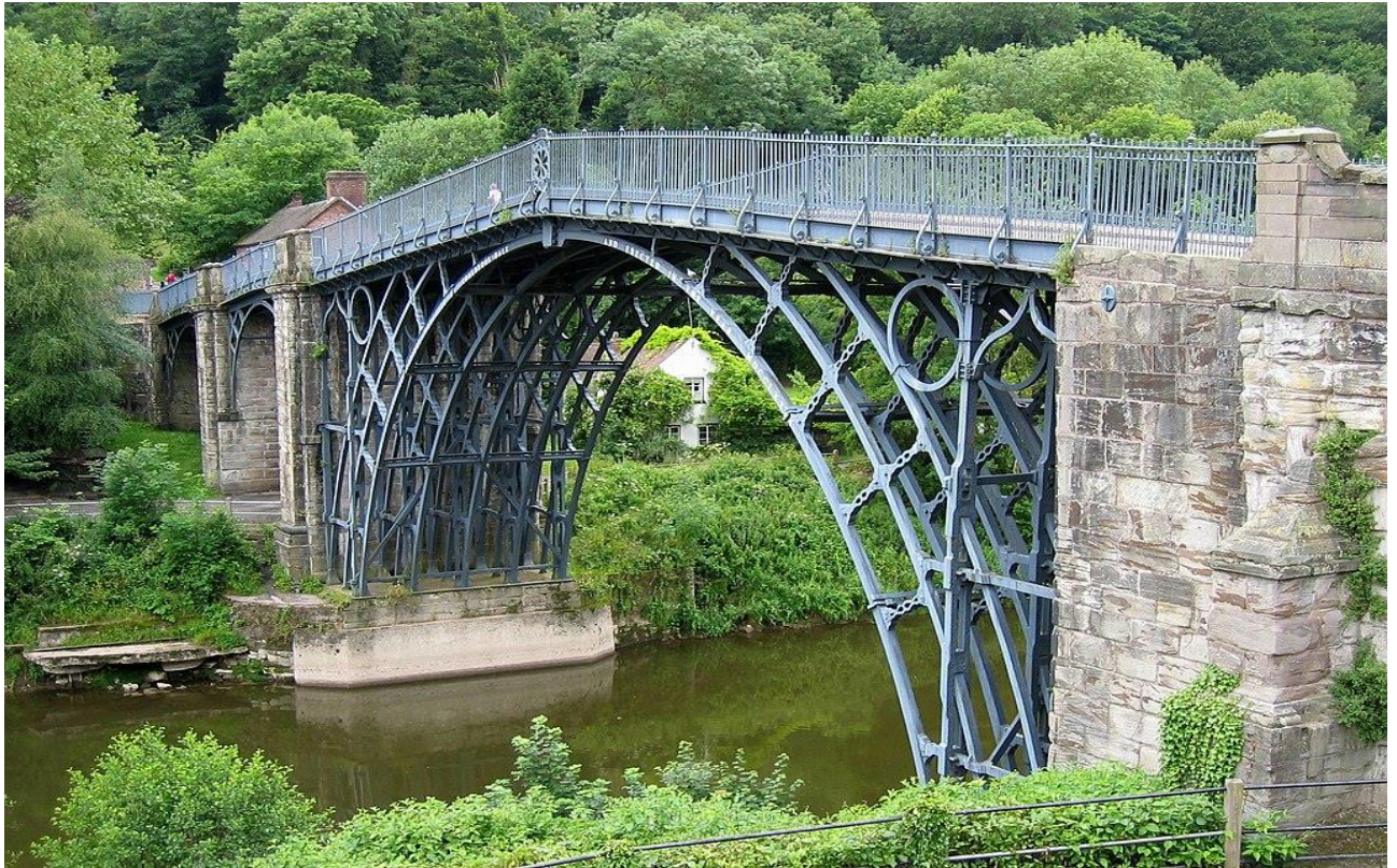
Рисунок 1.8 – Залізний міст — перший у світі арковий міст, виготовлений із заліза (чавуну), Велика Британія.
