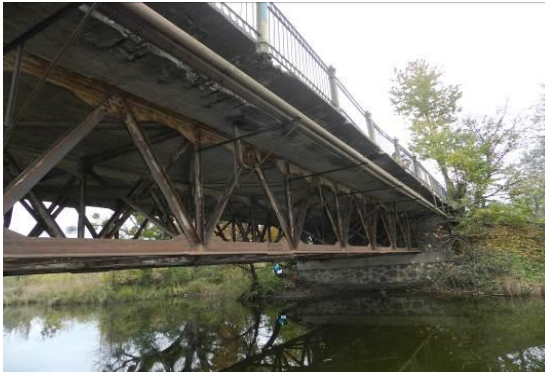
Рисунок 2.3 – Загальний вигляд сталезалізобетонної прогонової будови під проїзною частиною в осях «0-1».
