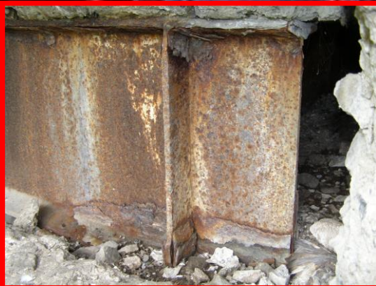
Руйнування захисного шару з корозією робочого армування
