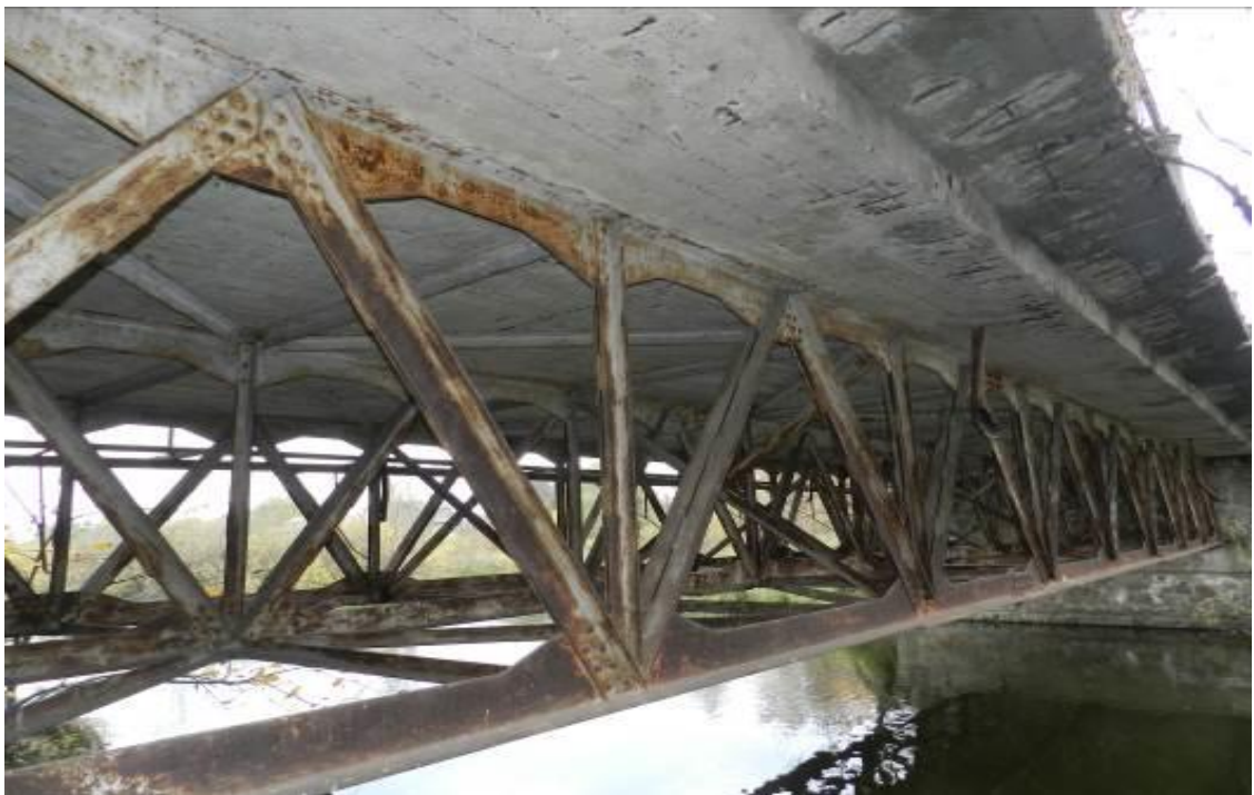
Рисунок 2.2 – Загальний вигляд сталезалізобетонної прогонової будови під проїзною частиною в осях «1-0».
