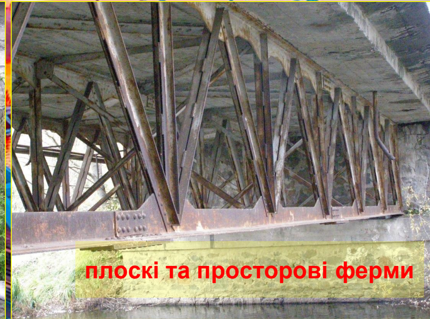
Кутики та таври з'єднані заклепками, високоміцними болтами, зварюванням
