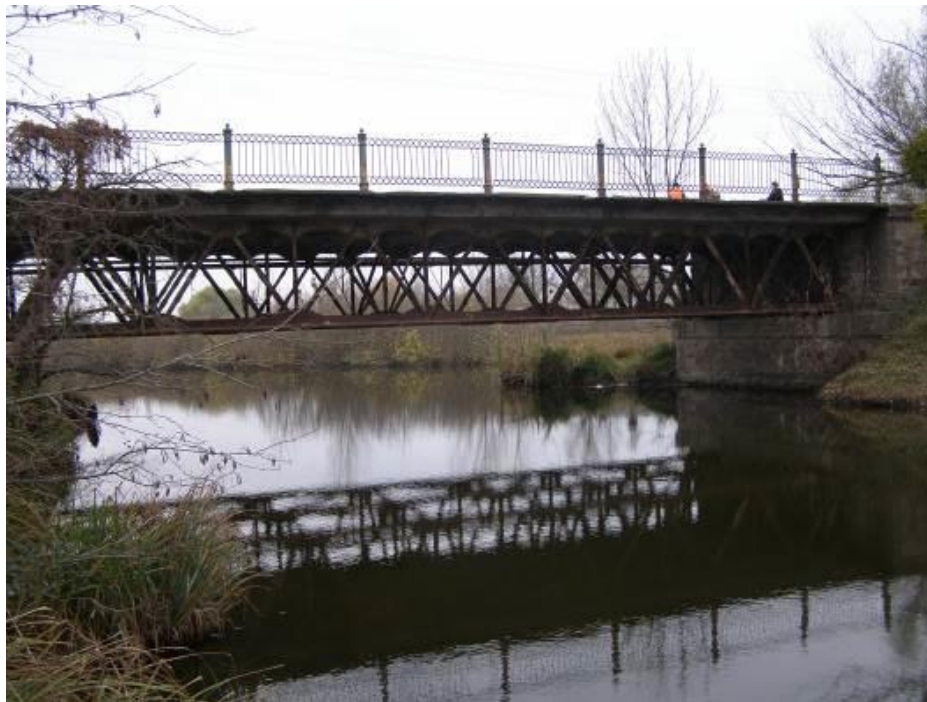
Рисунок 2.1 – Загальний вигляд мостової споруди взятої, як приклад
