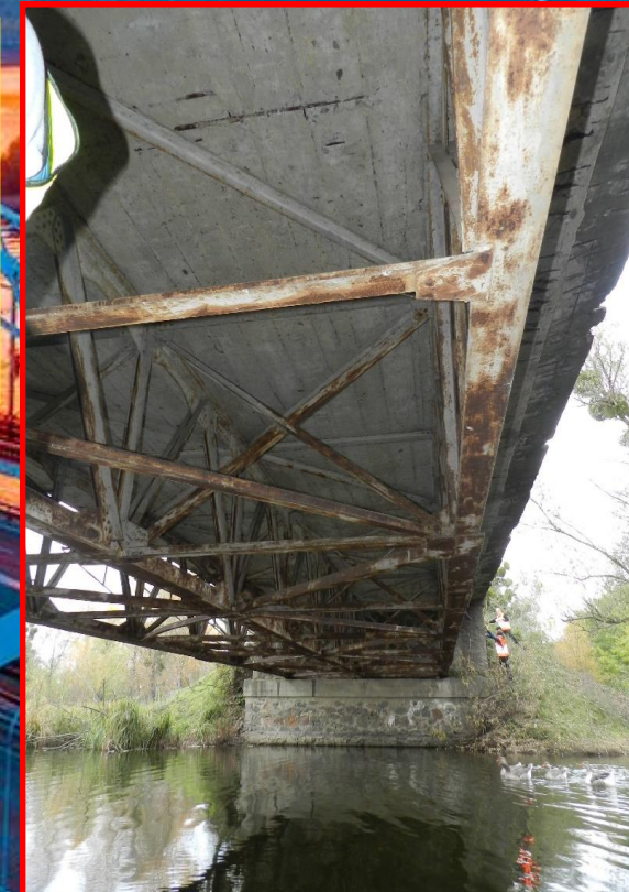
Викривлення, поверхнева та шарувата корозія опорних конструкцій)
