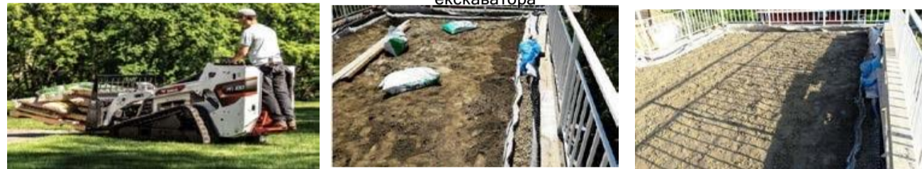
Влаштування газону окремими частинами на шар ґрунту в єдиний «килим»
