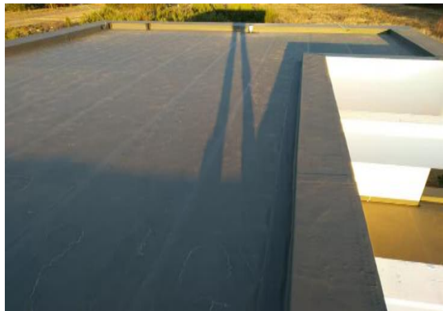
Рисунок 2.7 -AlphaThor тришарова гідроізоляційна мембрана
