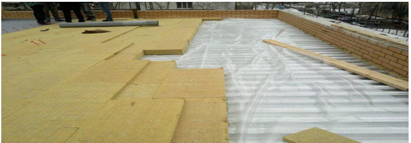
Рисунок 3.5 - Монтаж утеплювача
