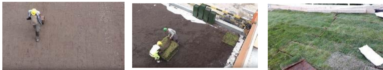
Влаштування газону окремими частинами на шар ґрунту в єдиний «килим»
