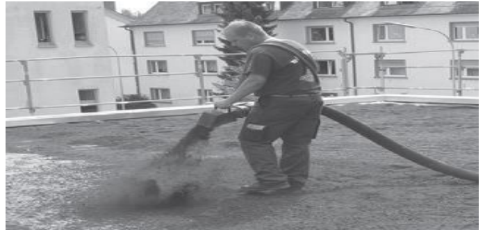
Рисунок 4.2 - Влаштування цементно-піщаної стяжки
