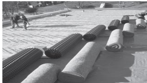
Рисунок 4.4 - Влаштування геотекстилю
