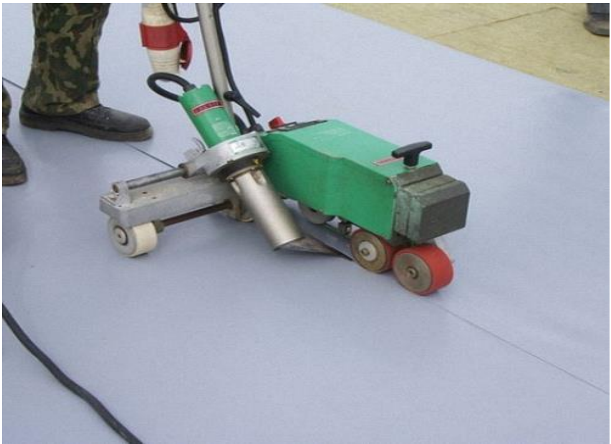
Рисунок 3.6 - Зварювання мембрани за допомогою обладнання
