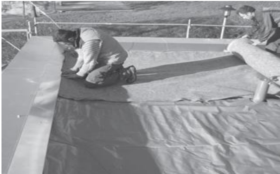
Рисунок 4.1 - Влаштування пароізоляції на даху
