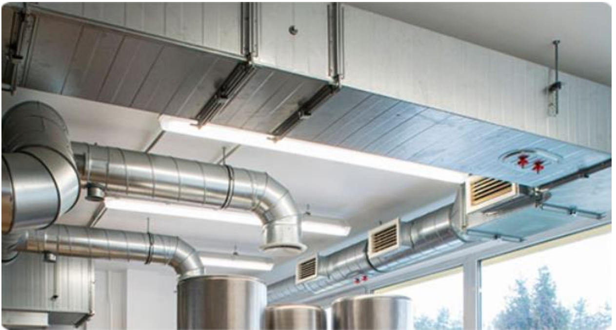
Рис. 1.1 – Повітропроводи загальнообмінної системи вентиляції
