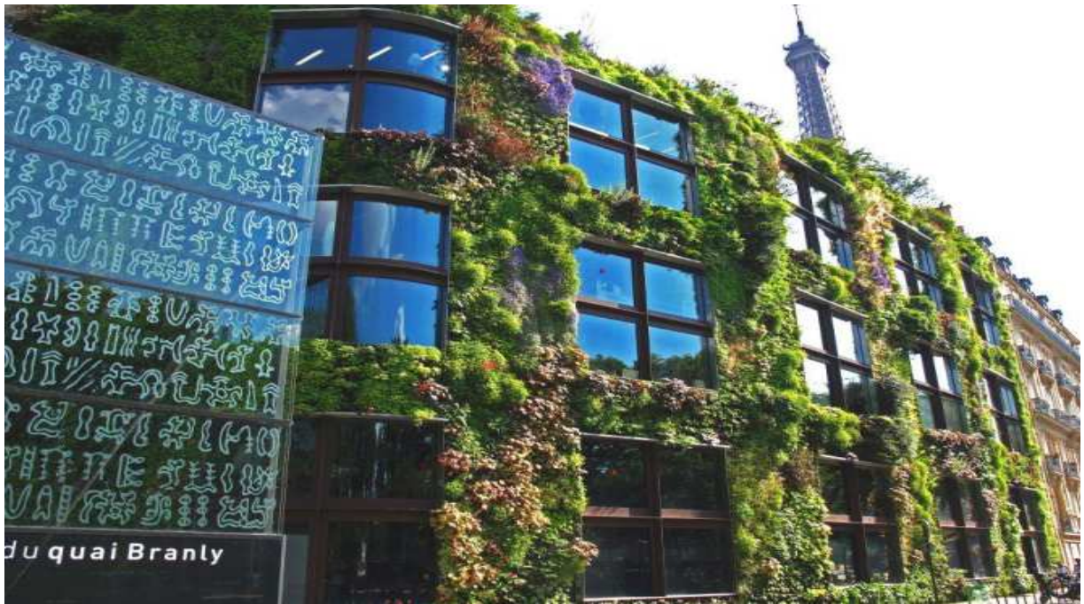
Рис. 2.8 Музей набережної Бранлі Грінволл (Quai Branly Museum) з живою стіною довжиною 200 м та висотою 12 м.
