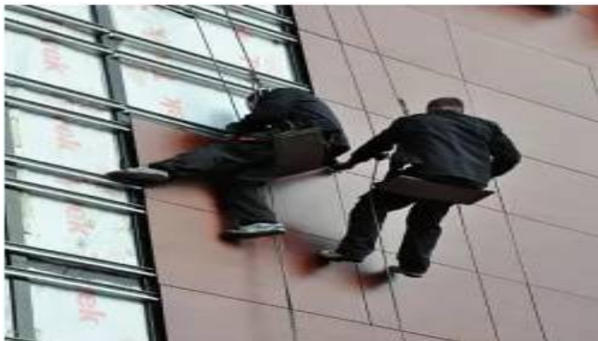
Рис. 4.13 Виконання робіт по влаштуванні вентиляльованого фасаду висотної будівлі (промисловий альпінізм).
