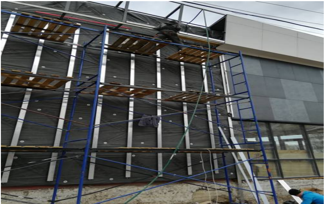
Рис. 4.15. Фрагмент влаштування вентильованого фасаду громадської будівлі з облицюванням керамогранітом в м. Вінниця пр. Юності
