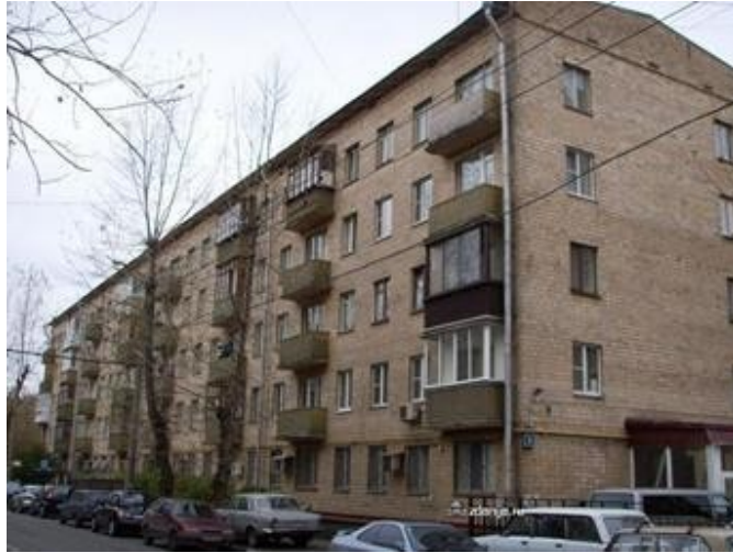
Рис. 4.5 – Цегляна п'ятиповерхова будівля
