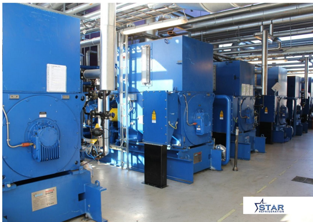
Рисунок 2.3 - Теплові насоси в муніципалітеті Драммен
