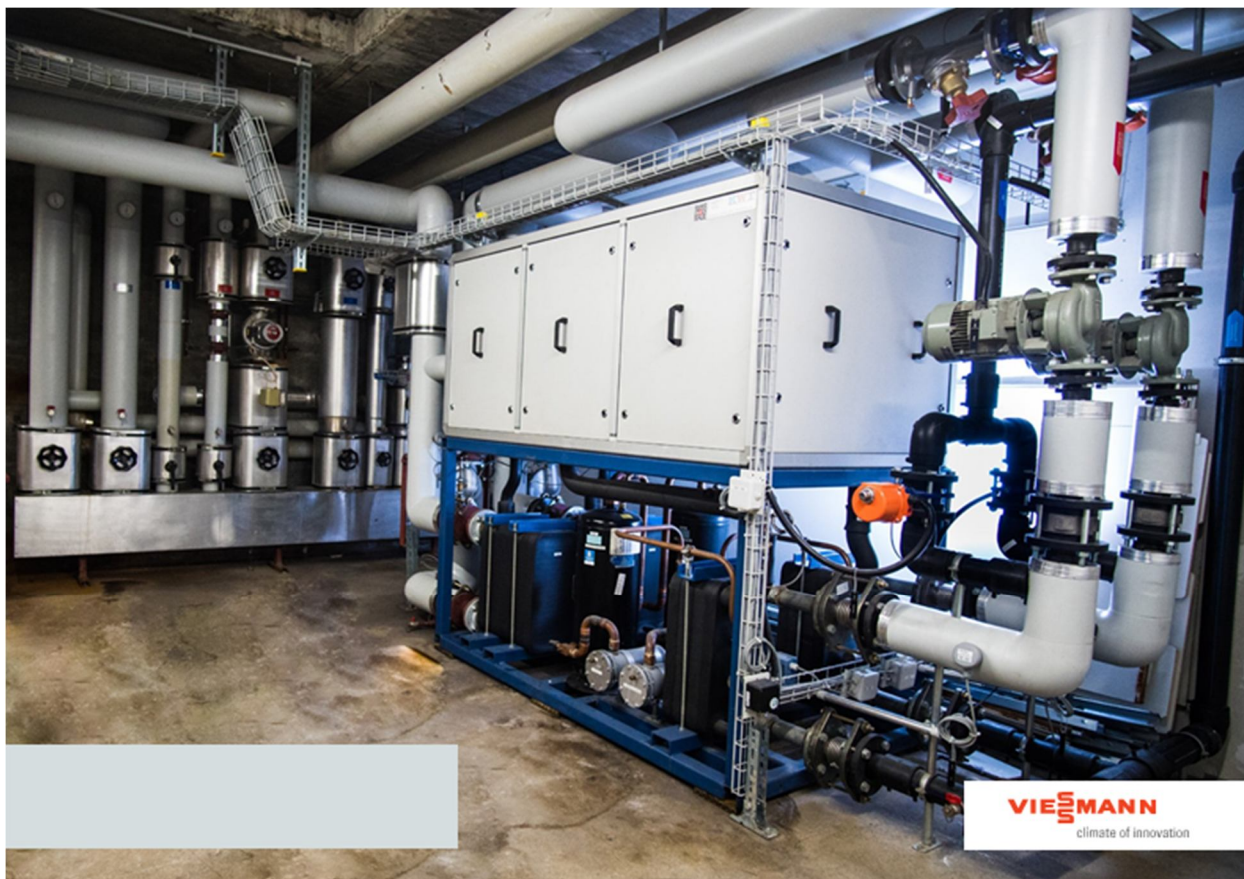
Рисунок 2.9 - Теплові насоси на заводі Nutrex
