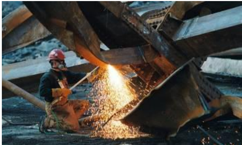
Рис. 1.8 – Різання металу киснево-газовим пальником
