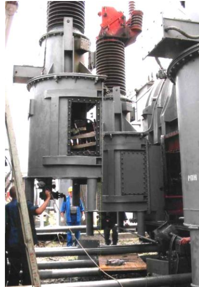
Рисунок 1.3 – Ремонт реактора та РПН автотрансформатора
