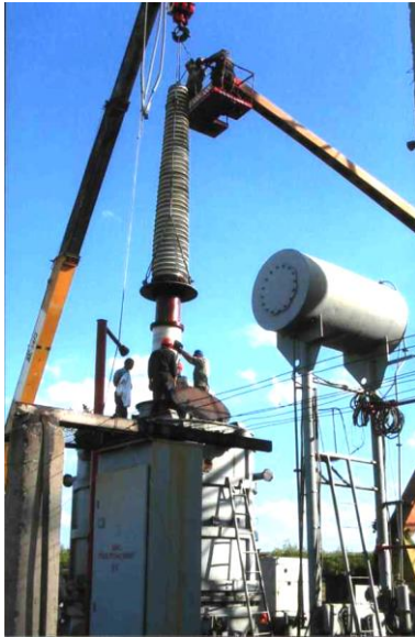
Рисунок 1.3 – Ремонт реактора та РПН автотрансформатора
