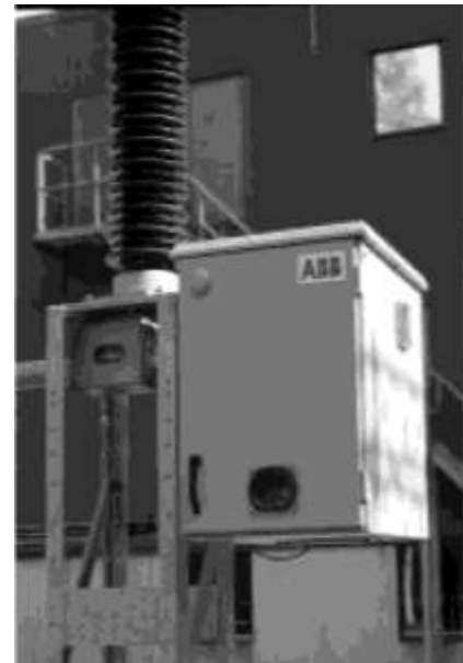
Рисунок 4.4 – Привод вимикача серії BLK
