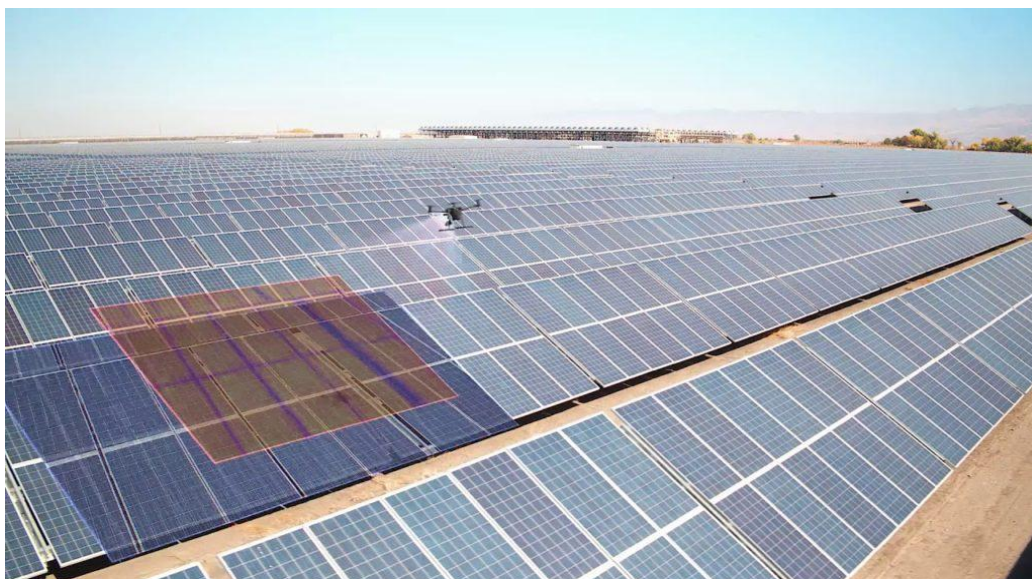
Рисунок 4.10. Визначення пошкоджених ФЕМ за допомогою квадрокоптеру.
