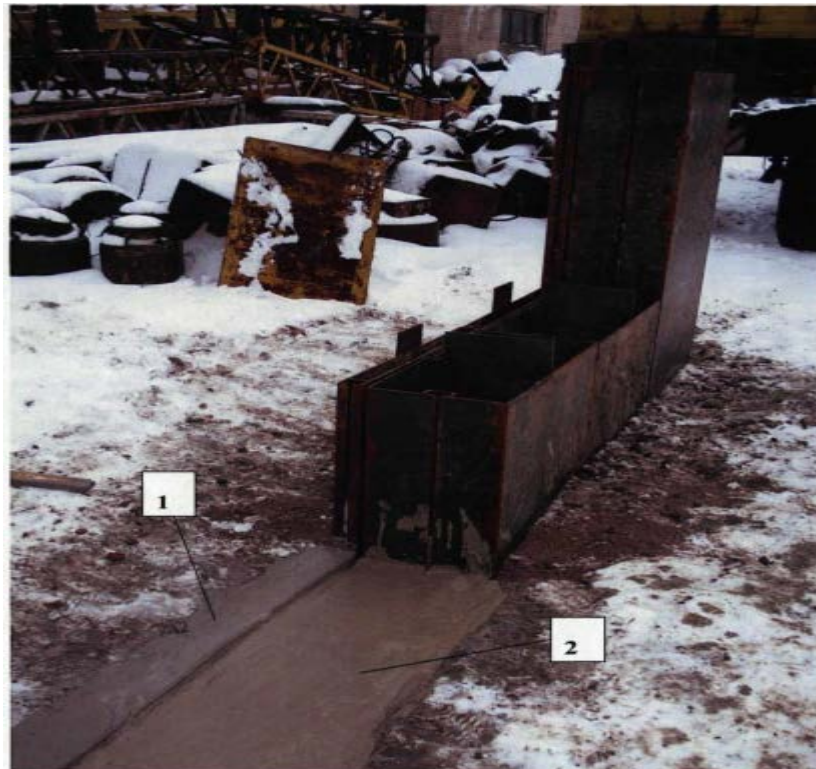
Рис.4.3 - Опробування технологічних прийомів зведення «стіни в ґрунті» за вібраційною технологією: 1 - гідроізоляційний екран, виконаний методом «стіна в ґрунті»; 2-бетонна стіна в ґрунті.
