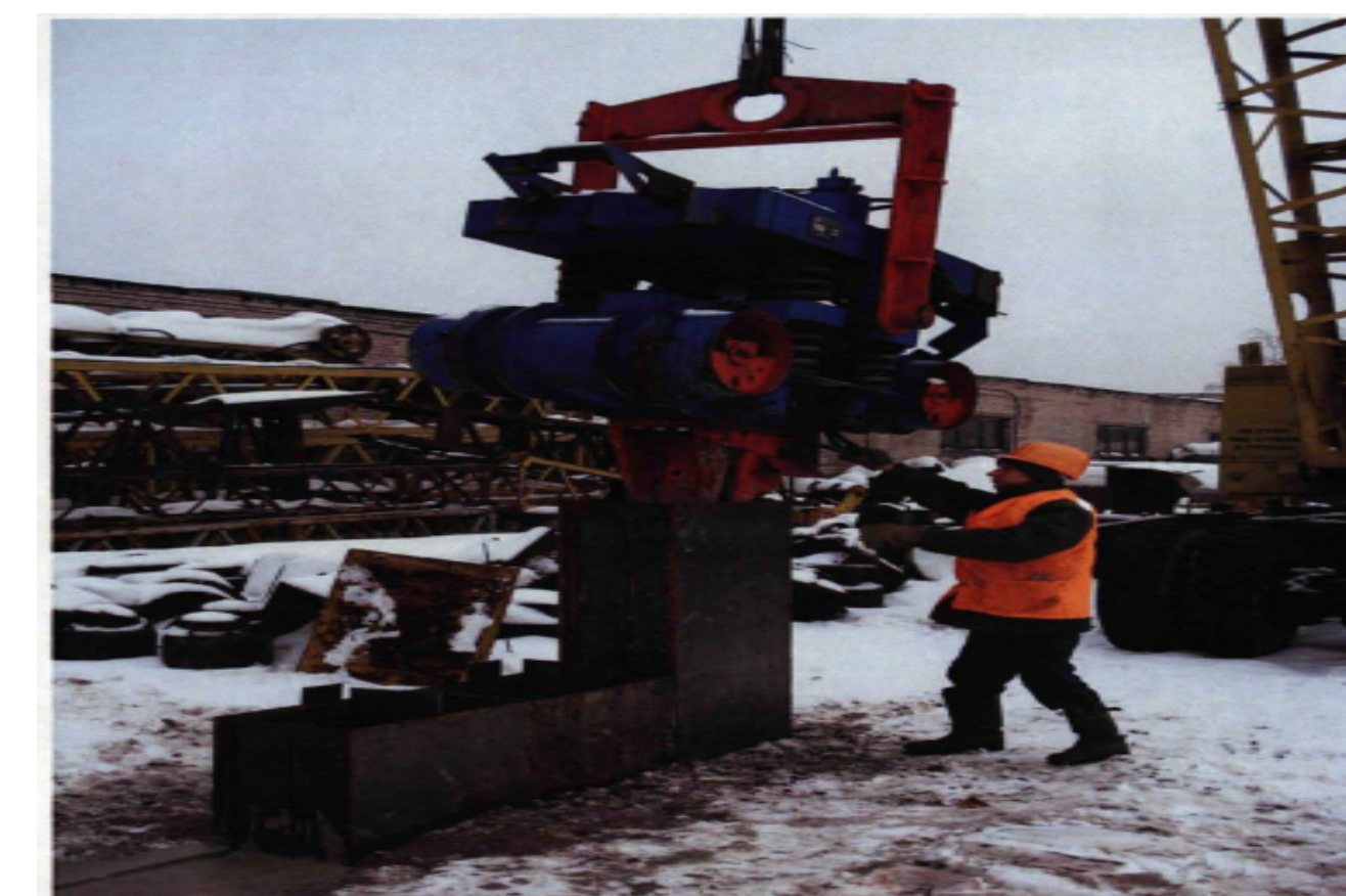
Рис. 7. Кріплення відрозанурювача до складового блоку профілю.
