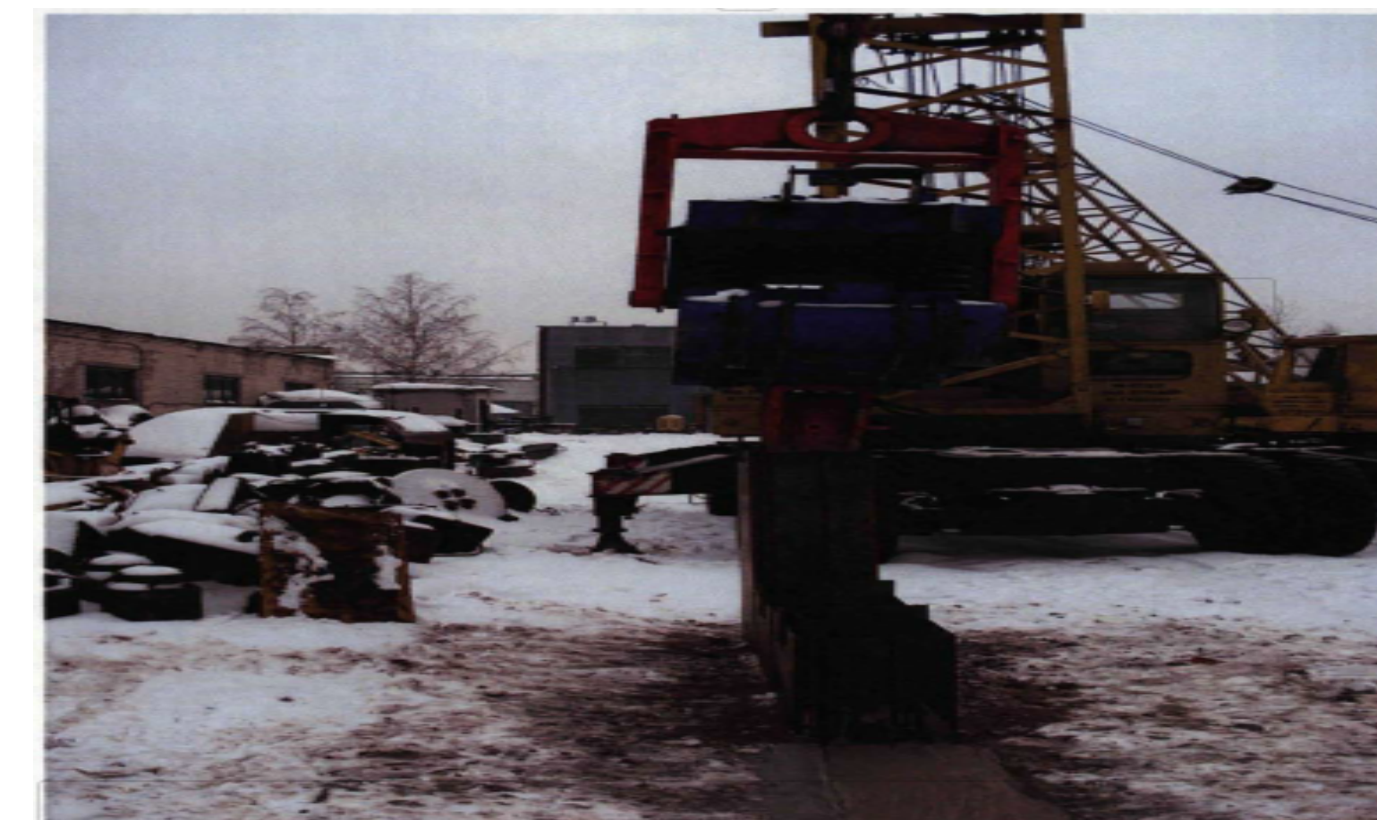
Рис. 5. Загальний вигляд верхньої частини «стіни у ґрунті», зведеної за вібраційною технологією.
