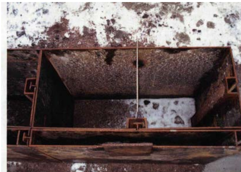
Рис. 4.5 - Вузли сполучення профільувальних елементів та кріплення профільувального елемента з віброзанурювачем.
