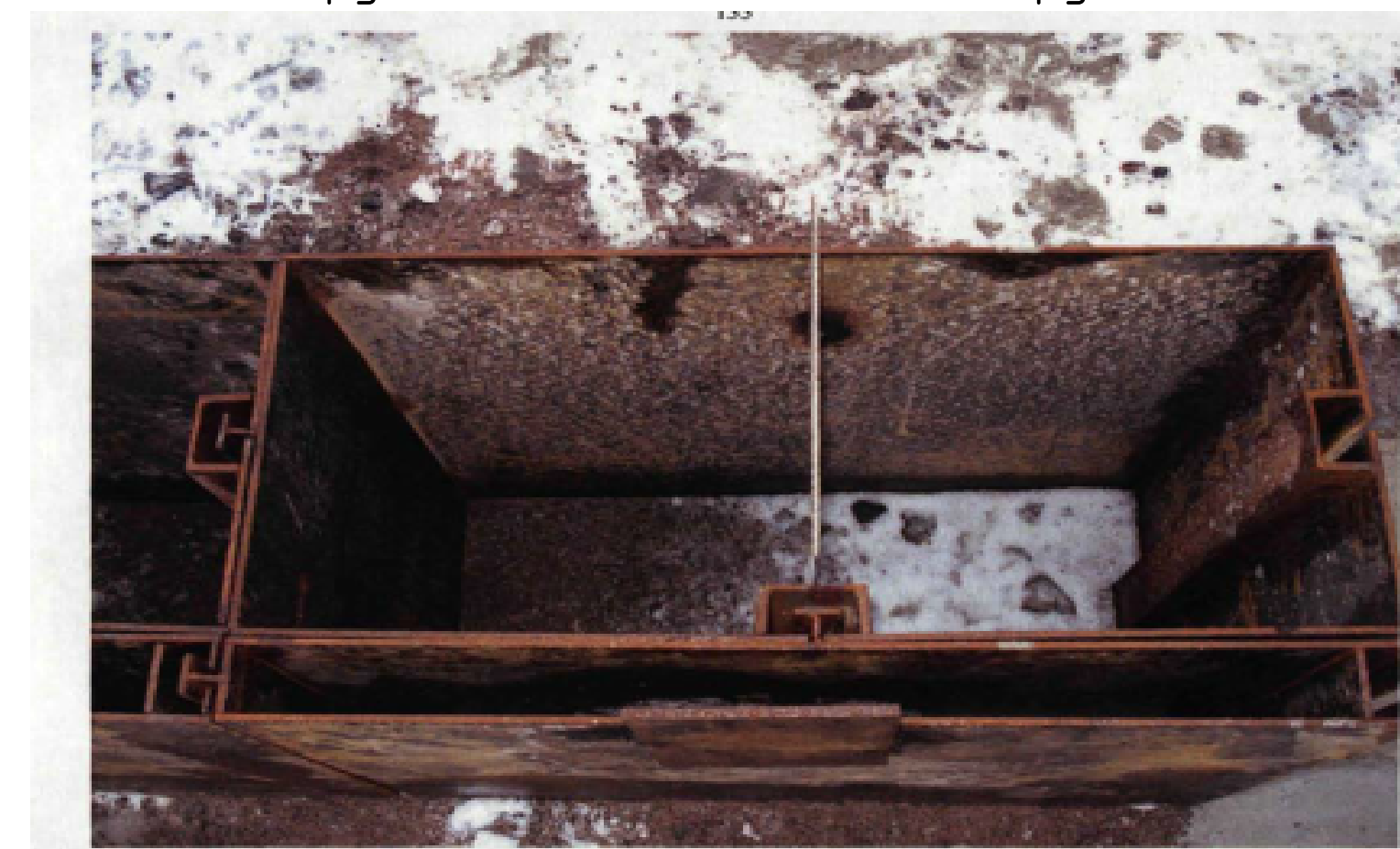
Рис. 4. Вузли сполучення профільувальних елементів та кріплення профільувального елемента з відрозанурювачем.
