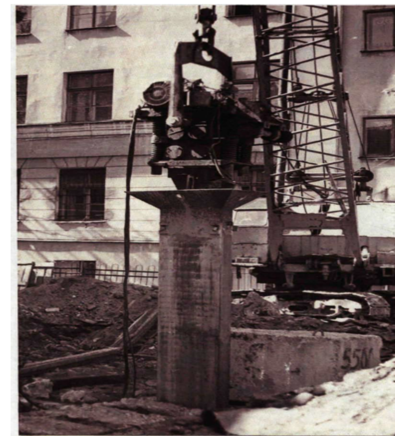
Рис.5 Виготовлення траншейного фундаменту без вилучення ґрунту за вібраційною технологією.
