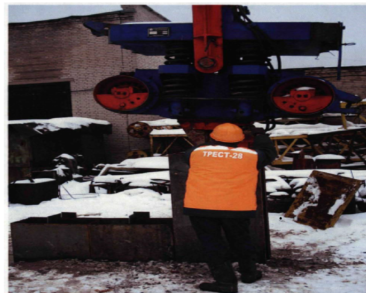
Рис. 6. Кріплення відрозанурювача до складового блоку профілю (вид збоку).
