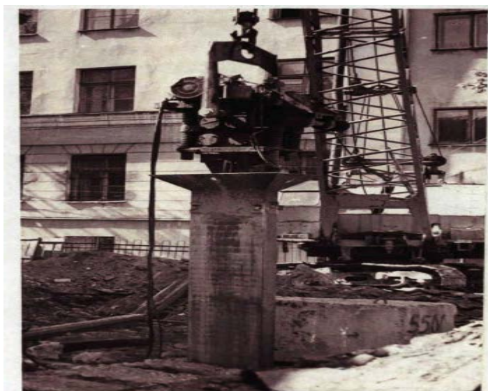
Рис.1.6 - Виготовлення траншейного фундаменту без вилучення ґрунту за вібраційною технологією.
