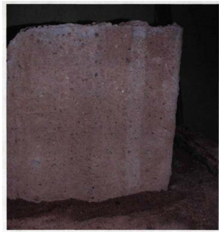
Рис.3.8 - Витягнута з ґрунту відформована гідроізольована бетонна «стіна в ґрунті» з втрамбуванням бетону в ґрунт.
