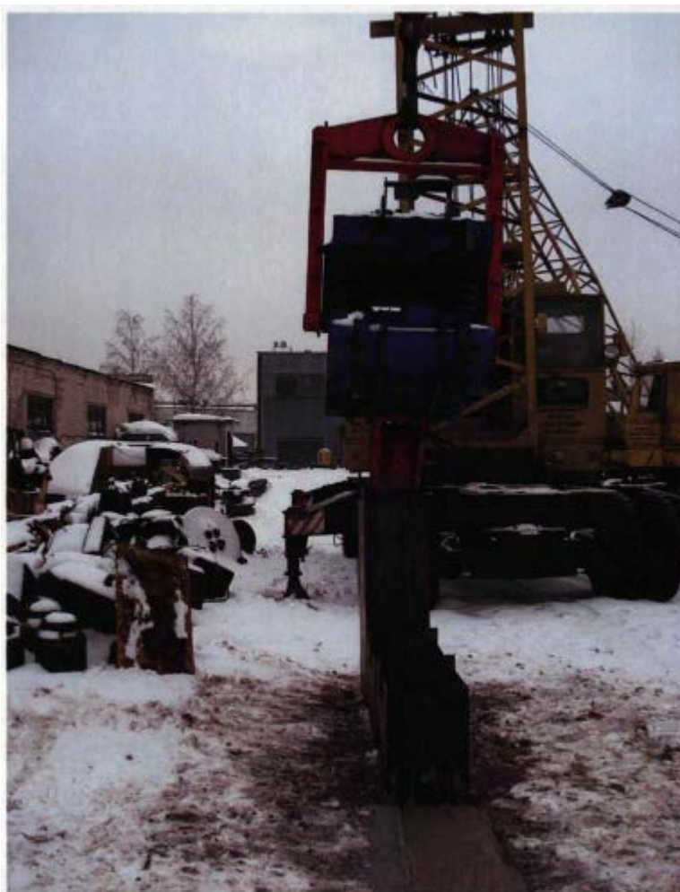
Рис. 4.6 - Загальний вигляд верхньої частини «стіни у ґрунті», зведеної за вібраційною технологією.
