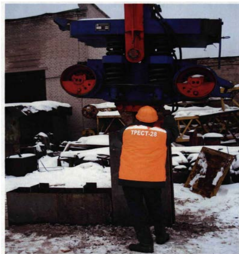
Рис. 4.7 - Кріплення віброзанурювача до складового блоку профілю (вид збоку).
