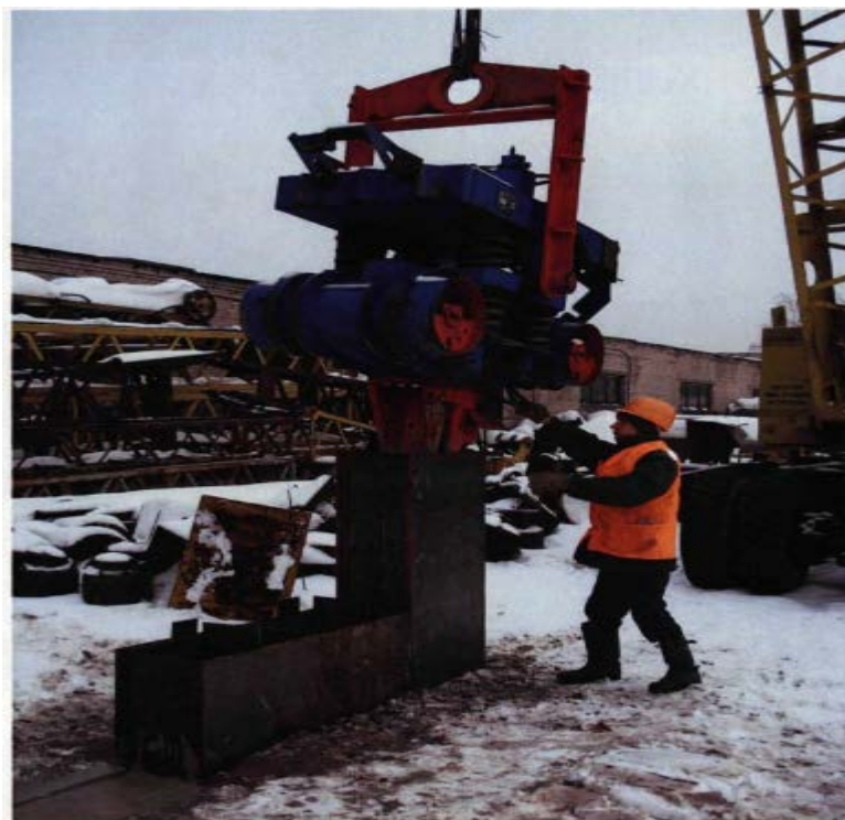
Рис. 4.8 - Кріплення віброзанурювача до складного блоку профілю.
