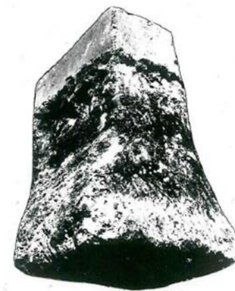
Фрагмент фундаменту з розширеною основою
