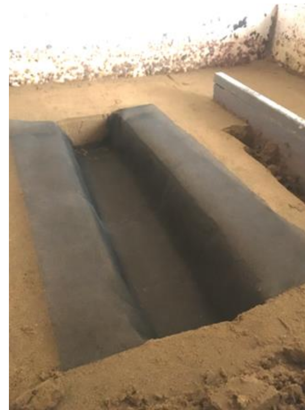
Розстилення армосітки По профілю траншеї
