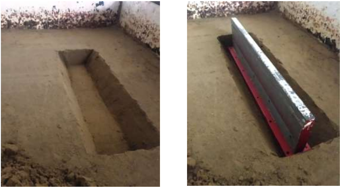
Рис. 2.6 – Траншея і стрічковий фундамент в траншеї
