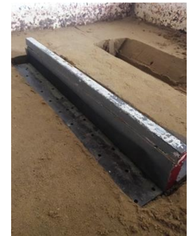
Встановлення жорсткого верхнього шару
