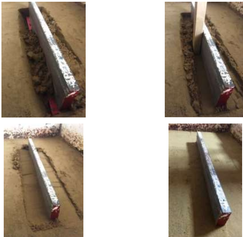
Рис. 2.7 – Послідовність зворотного засипання пазах траншеї
