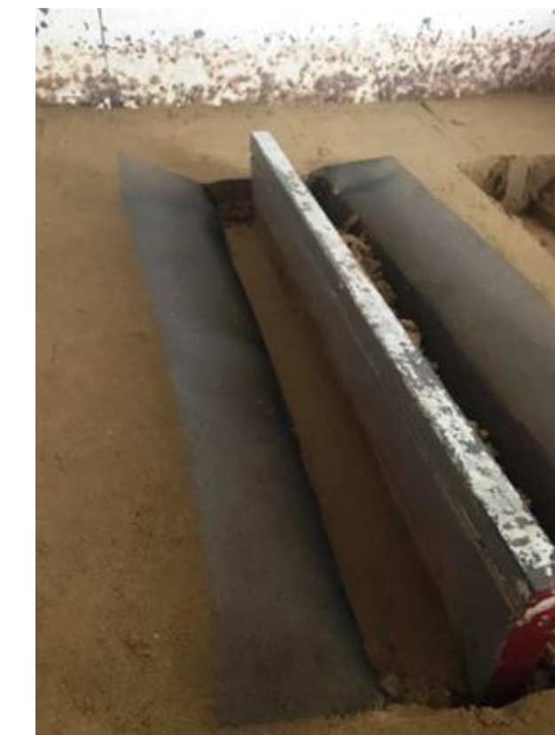
Зворотна засипка з пошаровим ущільненням
