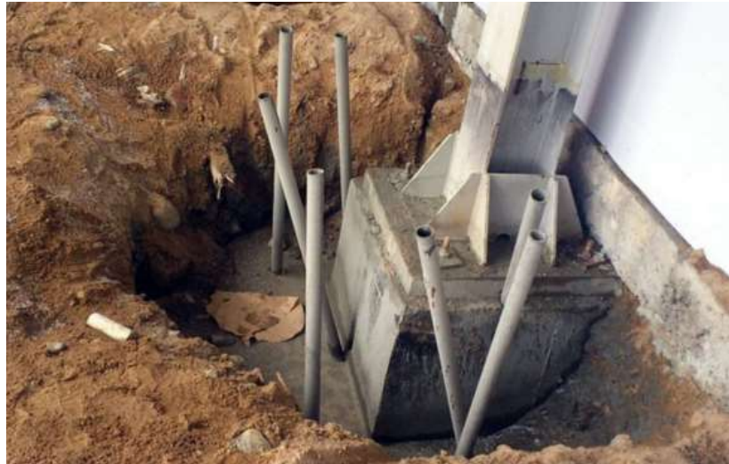
Рис. 1.1 – Підсилення основи ін'єкцією розчину
