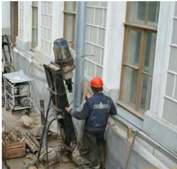
Рис. 1.8 - Підсилення фундаментів буроін'єкційними палями
