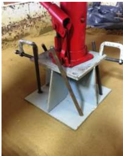
Рис. 2.6 – Встановлення елементів підсилення
