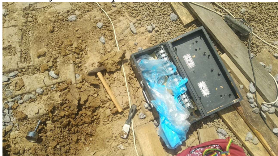
Рисунок 2.2 – Взяття зразків ґрунту з котловану
