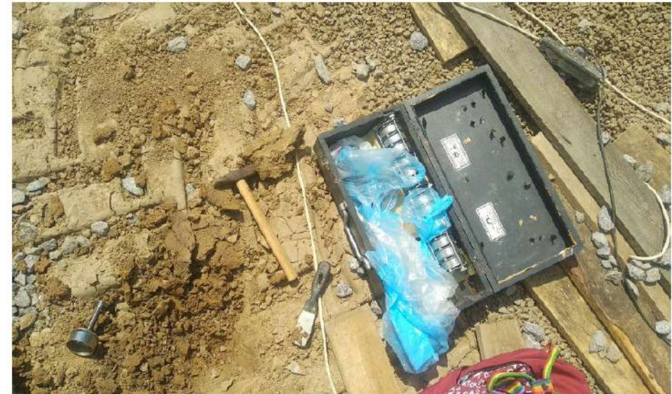
Рисунок 2.2 – Взяття зразків ґрунту з котловану
