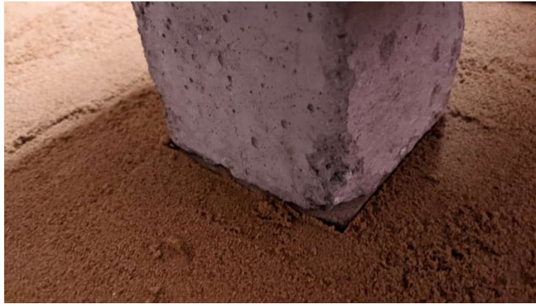
Рисунок 2.8 – Стан при руйнуванні ґрунта фундаментом, підсилимим банкетами в рівні підшви фундаменту
