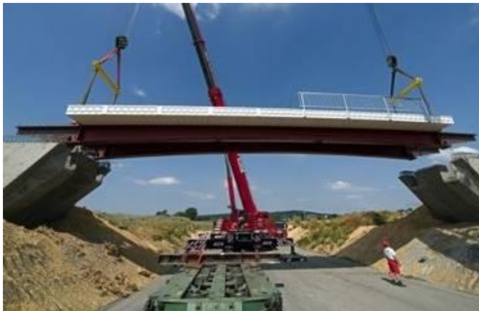
Рисунок 1.13 – Перший в Європі міст (2008 р. неподалік м. Фрідберг, Німеччина) з САП конструкцій
