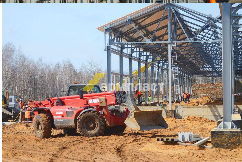
Рисунок 1.15 – Каркаси будівель із САП конструкцій
