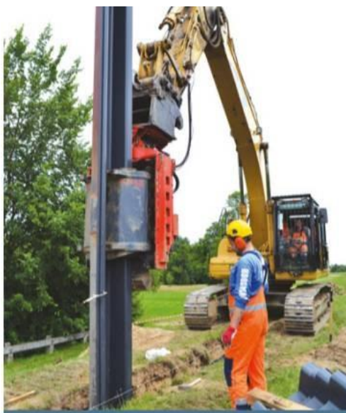
Рисунок 1.17– Встановлення шпунтових огорожень із САП конструкцій
