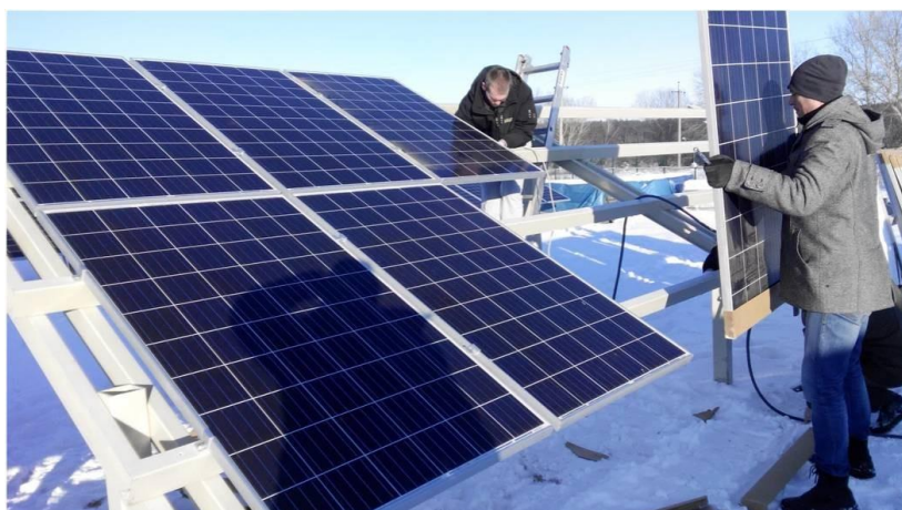
Рисунок 1.8 – Конструкція під сонячні батареї з САП конструкцій
