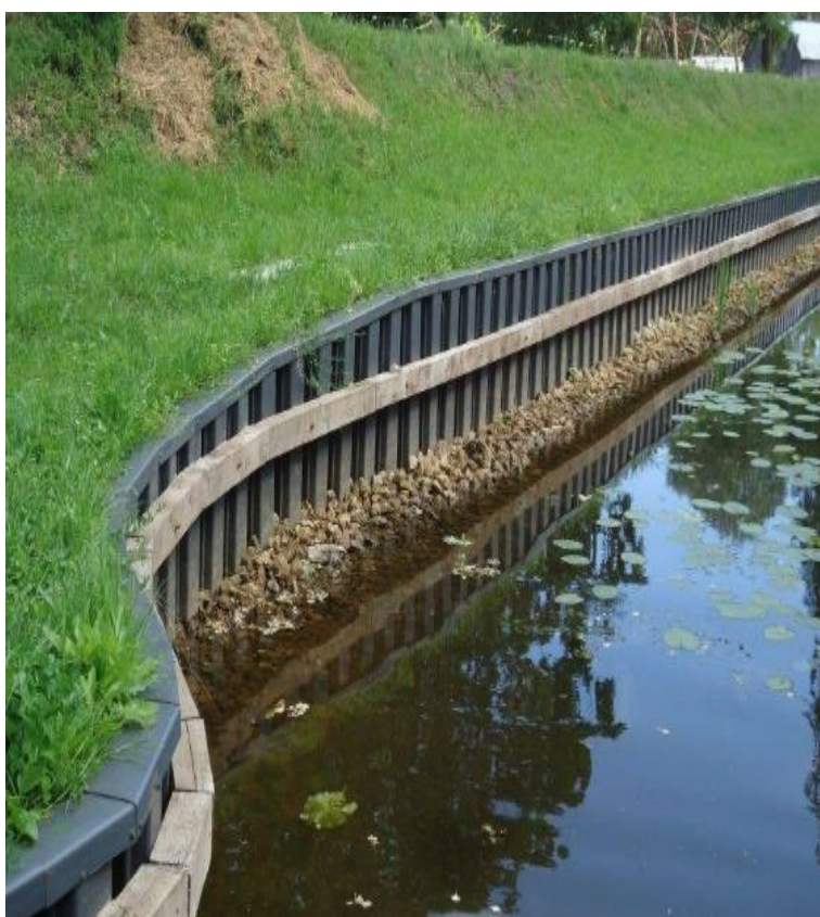
Рисунок 1.18– Шпунтове огороження із САП конструкцій
