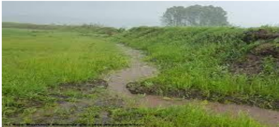
Рисунок 3.8 – Вало-канави для утримування дощової води
