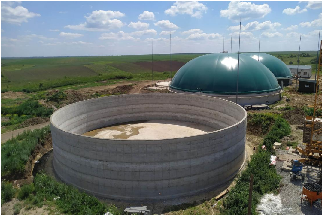
Рисунок 3.3 – Процес будівництва біогазового реактора
