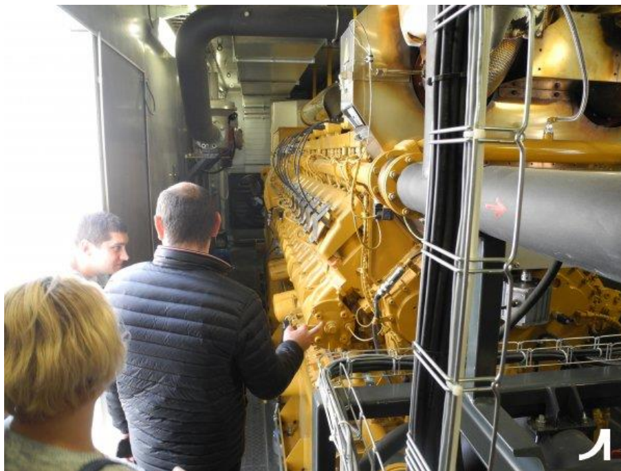
Рисунок 3.6 – Двигун когенератора
