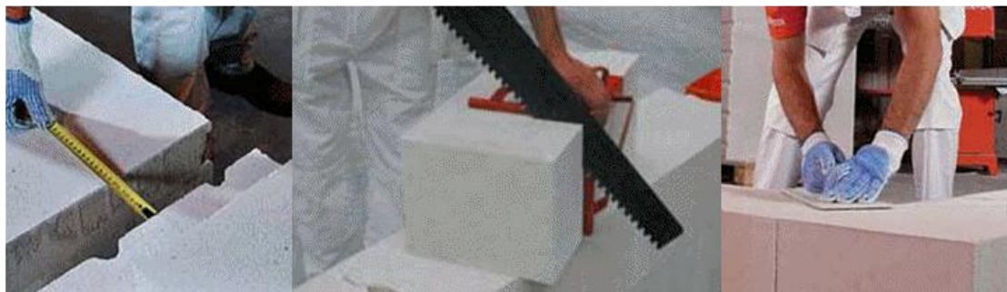
Рис.9. Виготовлення додаткових газобетонних блоків
