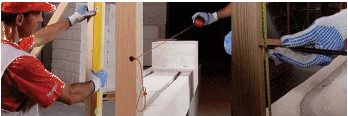
Рис.6. Схема разбивки рядів кладки
