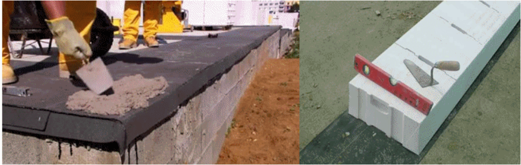
Рис.7. Підготовка та укладання першого ряду блоків
