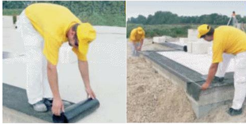
Рис.5. Влаштування гідроізоляції
