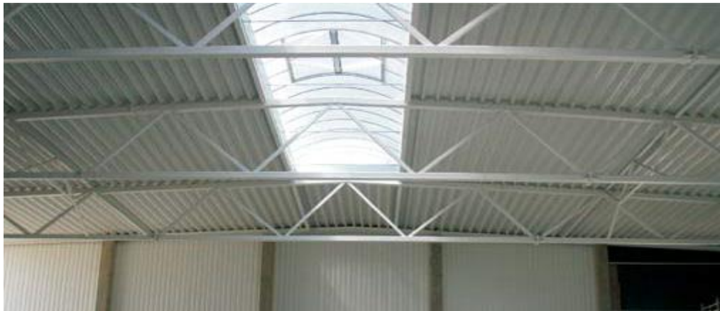
Рисунок 1.5. – Безпрогонна схема
