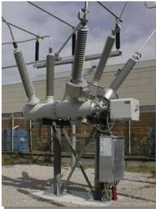
Комірка PASS M0 для однієї системи збірних шин
