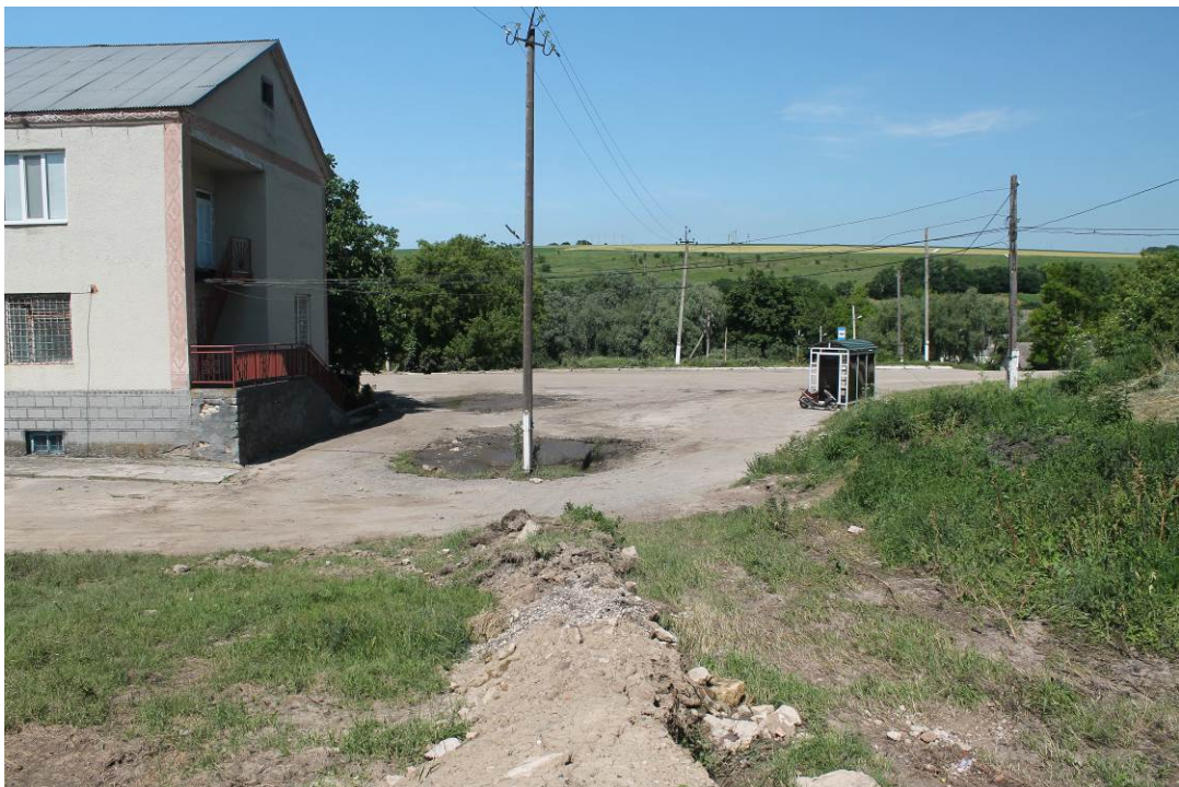
Рис. 2.1 – Загальний вид створу обстежуваної ділянки над водопропускною спорудою. Будівля сільради. Вид зі східного боку. Штучний захисний земляний насип (обвалування).
