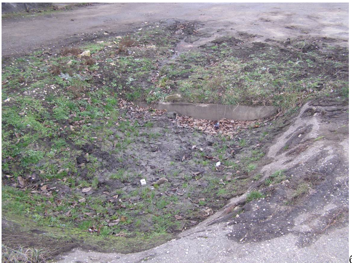
Рис. 2.5 – Загальний вид і стан дощоприймача №1: а – станом на 06.2019, б – на 12.2019. Застій опадових вод. Дощоприймач №1 занесений ґрунтом. Ґрунтові наноси поросли травою. Тріщини в асфальтобетонних схилах.
