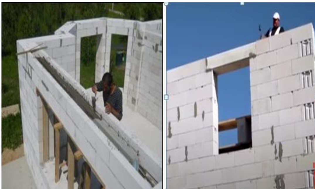
Рисунок. 2.6 – Зовнішній вигляд фасаду будівлі з використанням U-блоків
