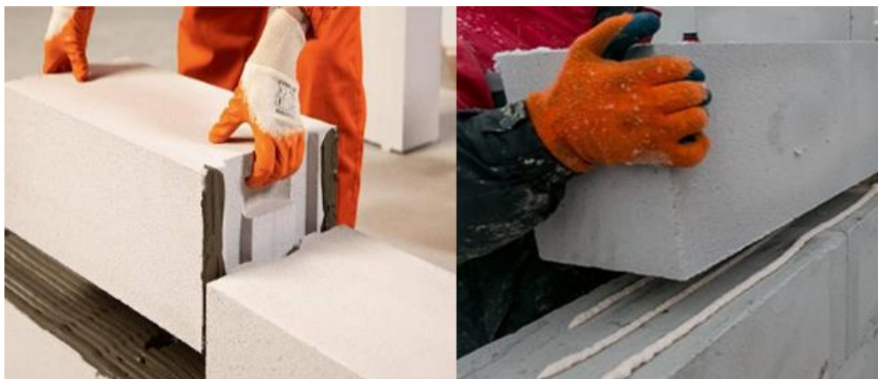
Рисунок 3.6 – Фрагменти кладки стін з використанням мінерального та пінополіуретанового клею.
