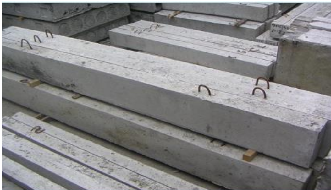
Рисунок.2.3 – Збірні залізобетонні перемички
