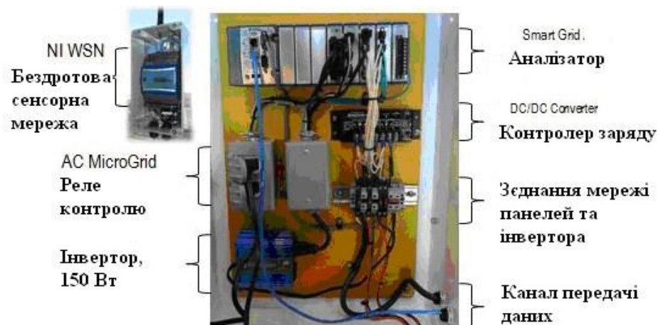
Рисунок 2.10 – Вузли моніторингу ФЕС компанії National Instruments
