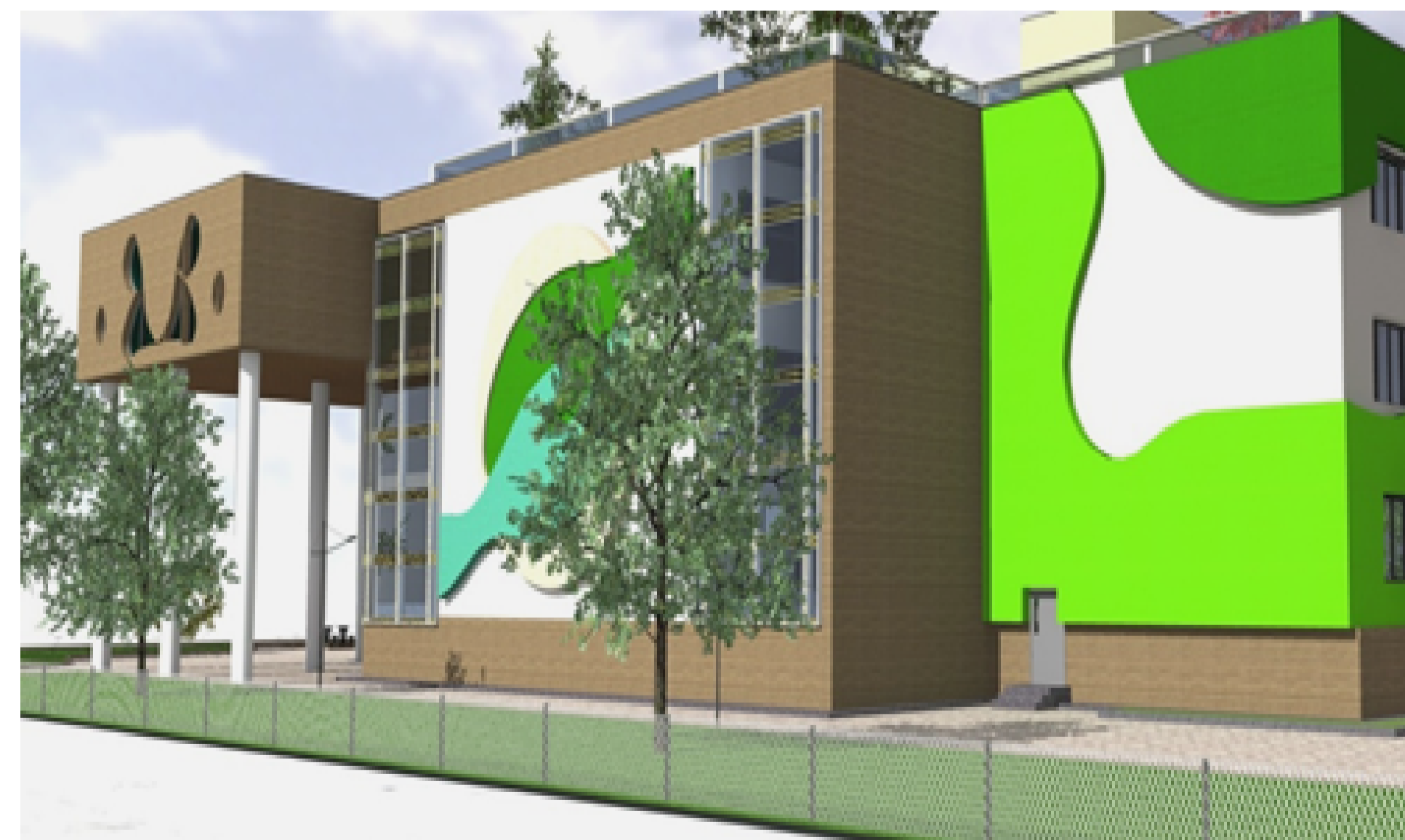
Західна стіна школи-гімназії, яка утеплена конструкцією підвищеної теплоізоляції фасаду.
