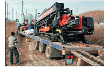
Доставка обладнання на будівельний майданчик
