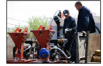
Приготування бентонітового розчину
