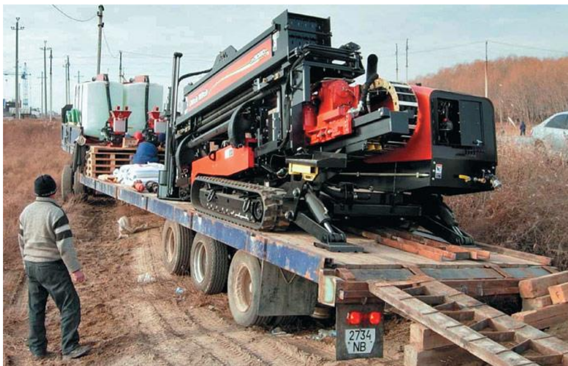
Рисунок 4.3 – Доставка обладнання на будівельний майданчик
