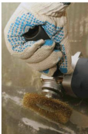
Рисунок 3.8 – Усунення відшарувань на укосах за допомогою електрошліфувальної машини
