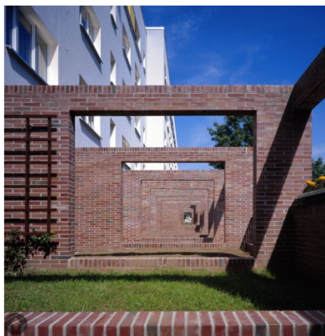
Рисунок 1.3 – Цегляна кладка уздовж першого поверху будівлі
