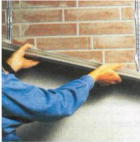
Рисунок 3.9 – Розрівнювання правилом нанесеної штукатурної суміші
