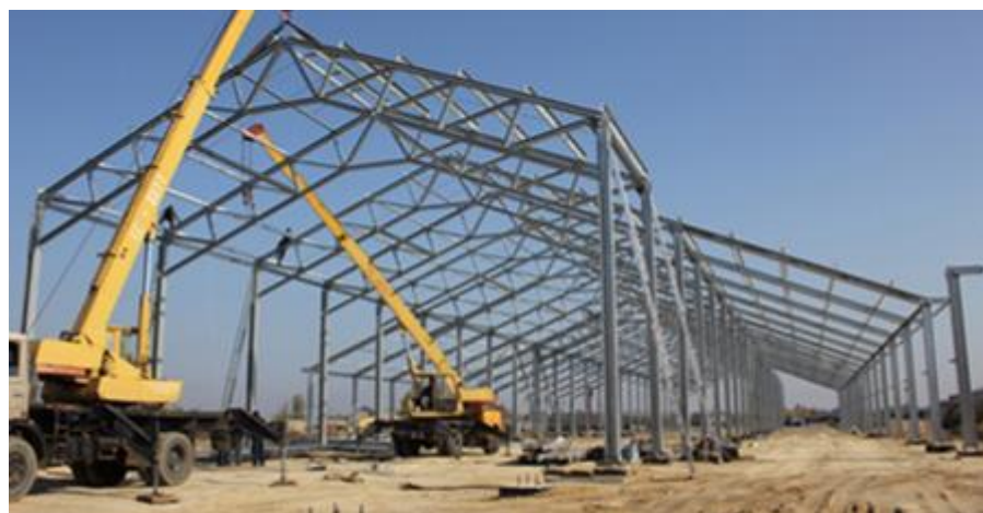
Рисунок 3.3 – Металевий каркас автосервісу
