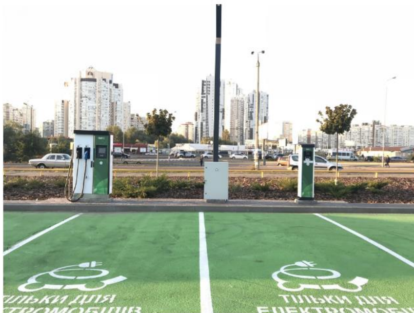
Рисунок 2.4 – Приклад влаштування електрозаправки
