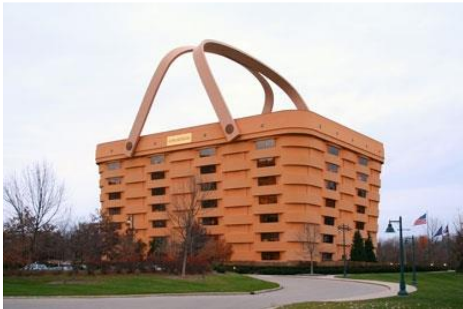
Рис. 1.4. Будівля офісного центру компанії «Longaberger» в США
