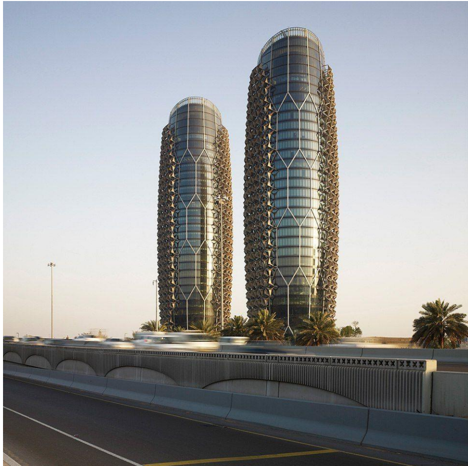
Рис. 1.3 Будівлі офісного центру в Об'єднаних арабських еміратах.
