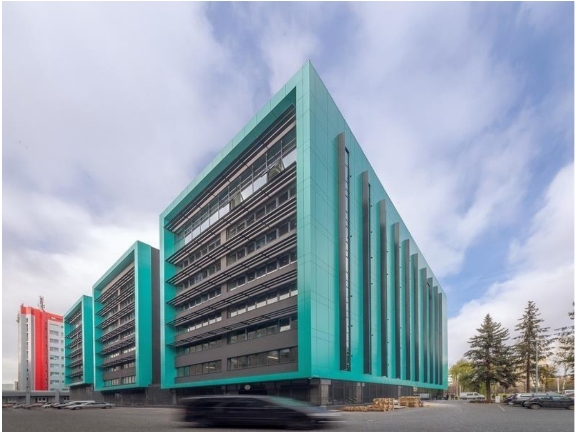
Рис. 1.9 Будівля офісного центру у м. Львів класу А
