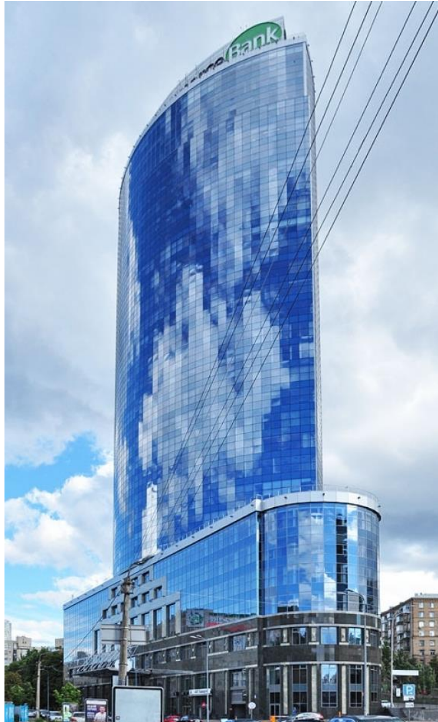
Рис. 1.6. Багатоповерхова будівля офісного центру "Парус" м. Київ
