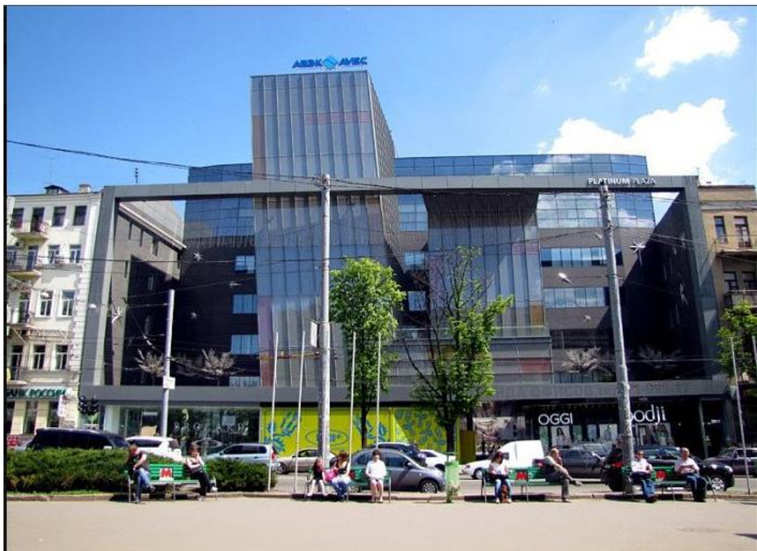
Рис. 1.7. Будівля офісного центру «Platinum Plaza» (Харків)
