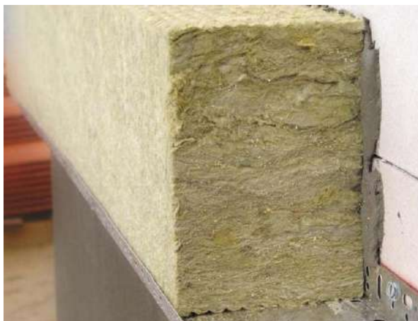
Рисунок 2.10 – Приклейка теплоізоляційних плит
