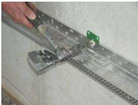
Рисунок 2.6 – Закріплення цокольного профілю дюбелями.
