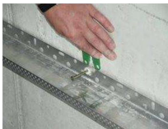
Рисунок 2.5 – Усунення нерівностей основи при допомозі дистанційних прокладок.
