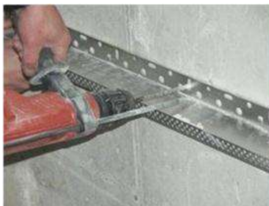
Рисунок 2.4 – Свердління отворів.
