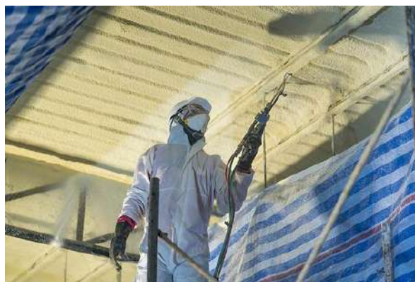
Рисунок 1.4 – Нанесення поліуретану
