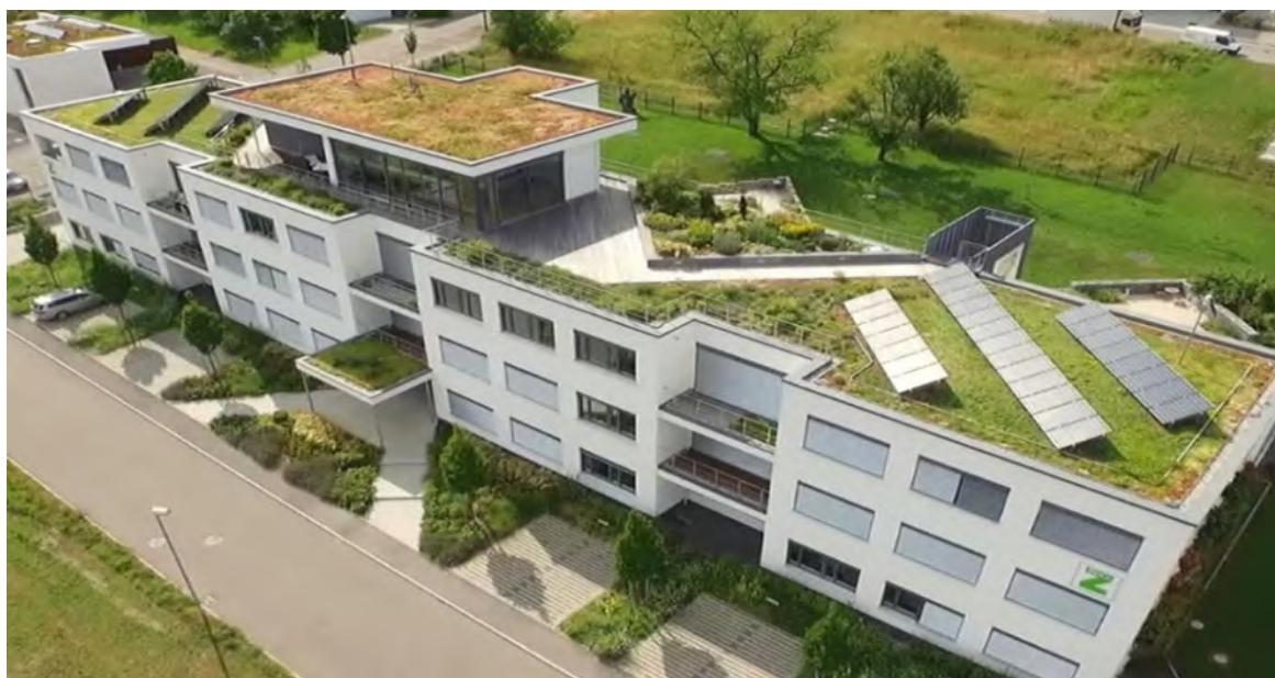
Рисунок 1.11 – Вигляд житлового будинку після реконструкції
