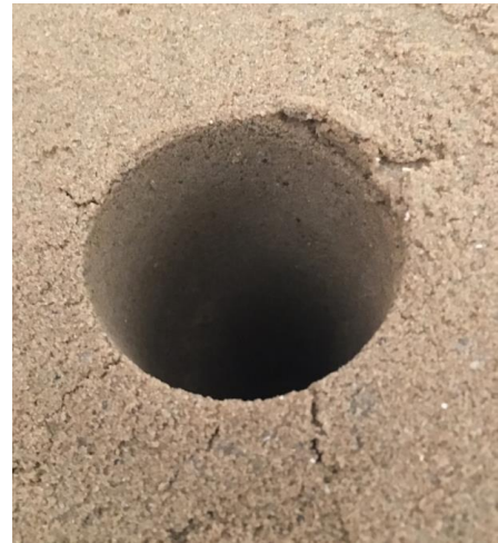
Рис. 2.4 - Влаштування свердловини в ґрунтовій основі
