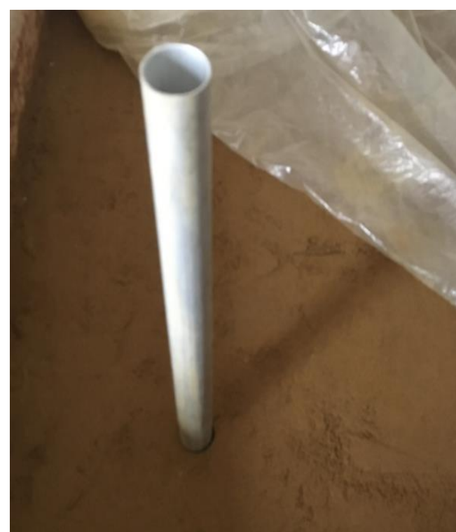
Влаштування свердловини в ґрунтовій основі
