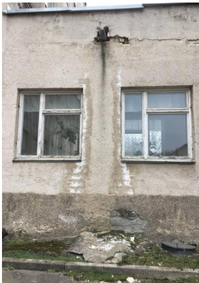
Рис. 3.3 – Результати порушення водовідведення з покрівлі а) - замокання конструкції стіни; б) – руйнування конструкції стіни; в) – відшарування штукатурки і поява плісняви
