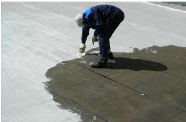
Рис. 1.9 – Використання фарби-мембрани для ремонту
