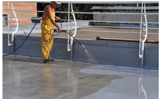
Рис. 1.9 – Використання фарби-мембрани для ремонту
