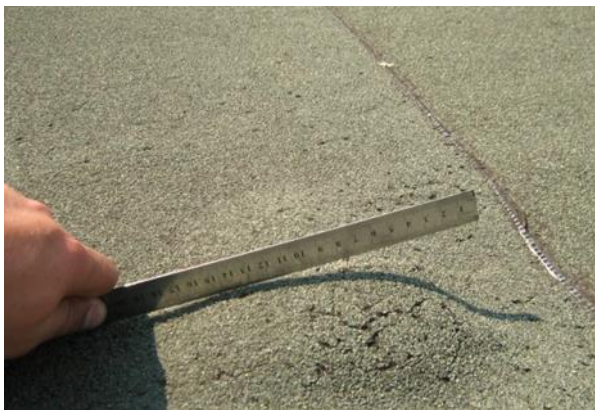
Рис.3.2 – Здуття покрівлі під дією пари вологи і розкривання пухирів
