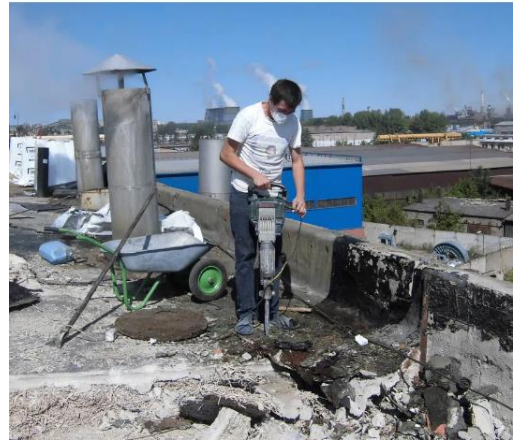
Рисунок 1.7 - Повна заміна старої покрівельної конструкції
