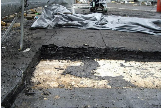
Рисунок 1.7 - Повна заміна старої покрівельної конструкції
