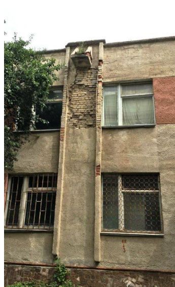
Рис. 3.3 – Результати порушення водовідведення з покрівлі а) - замокання конструкції стіни; б) – руйнування конструкції стіни; в) – відшарування штукатурки і поява плісняви
