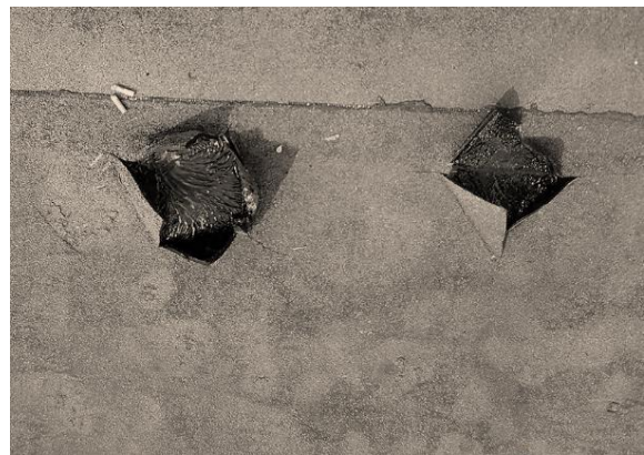
Рис.3.2 – Здуття покрівлі під дією пари вологи і розкривання пухирів
