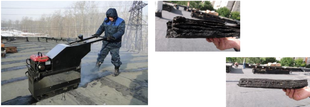
Рис. 1.10 – Ремонт методом спікання шарів покрівлі
