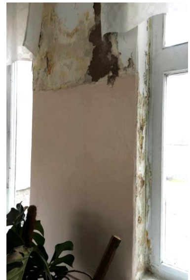
Рис. 3.3 – Результати порушення водовідведення з покрівлі а) - замокання конструкції стіни; б) – руйнування конструкції стіни; в) – відшарування штукатурки і поява плісняви
