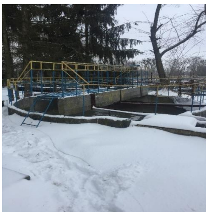
Рис.2.3 - Піскоуловлювачі
