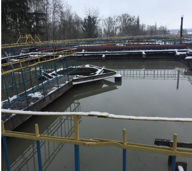
Рис. 2.4 - Первинні горизонтальні відстійники
