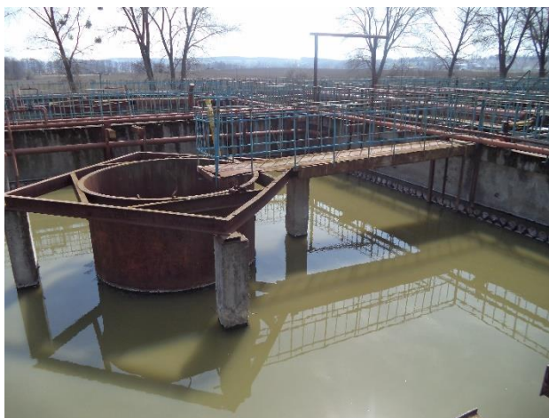
Рис. 2.8 – Контактні резервуари
