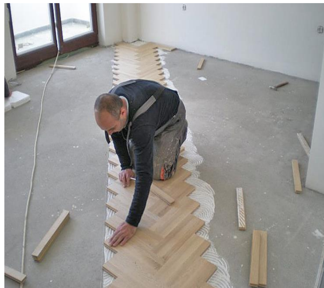
Клейове кріплення паркетних планок
