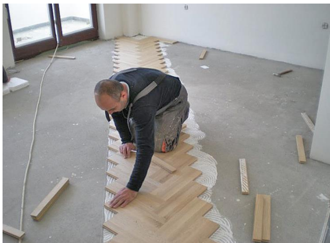
Рис. 2.5 – Клейове кріплення паркетних планок
