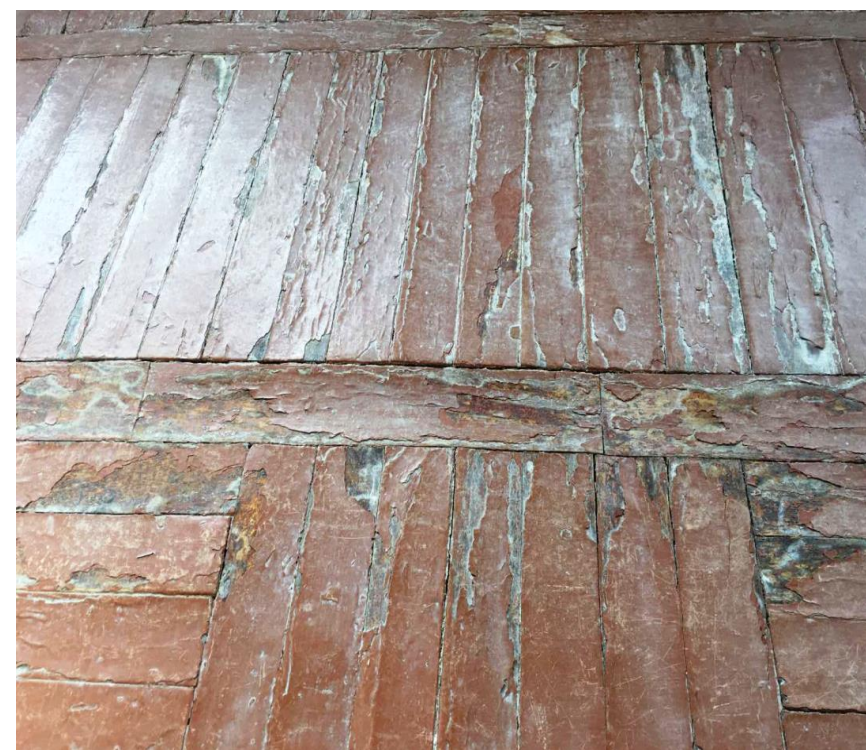
Деформації паркетних дощок при тривалому затопленні
