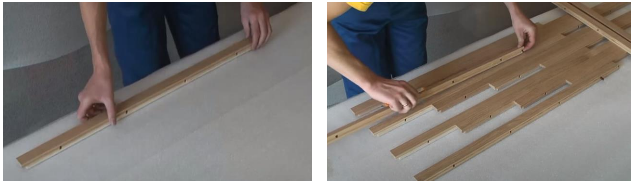
Рис. 2.7 – Вкладання паркетних планок з отворами
