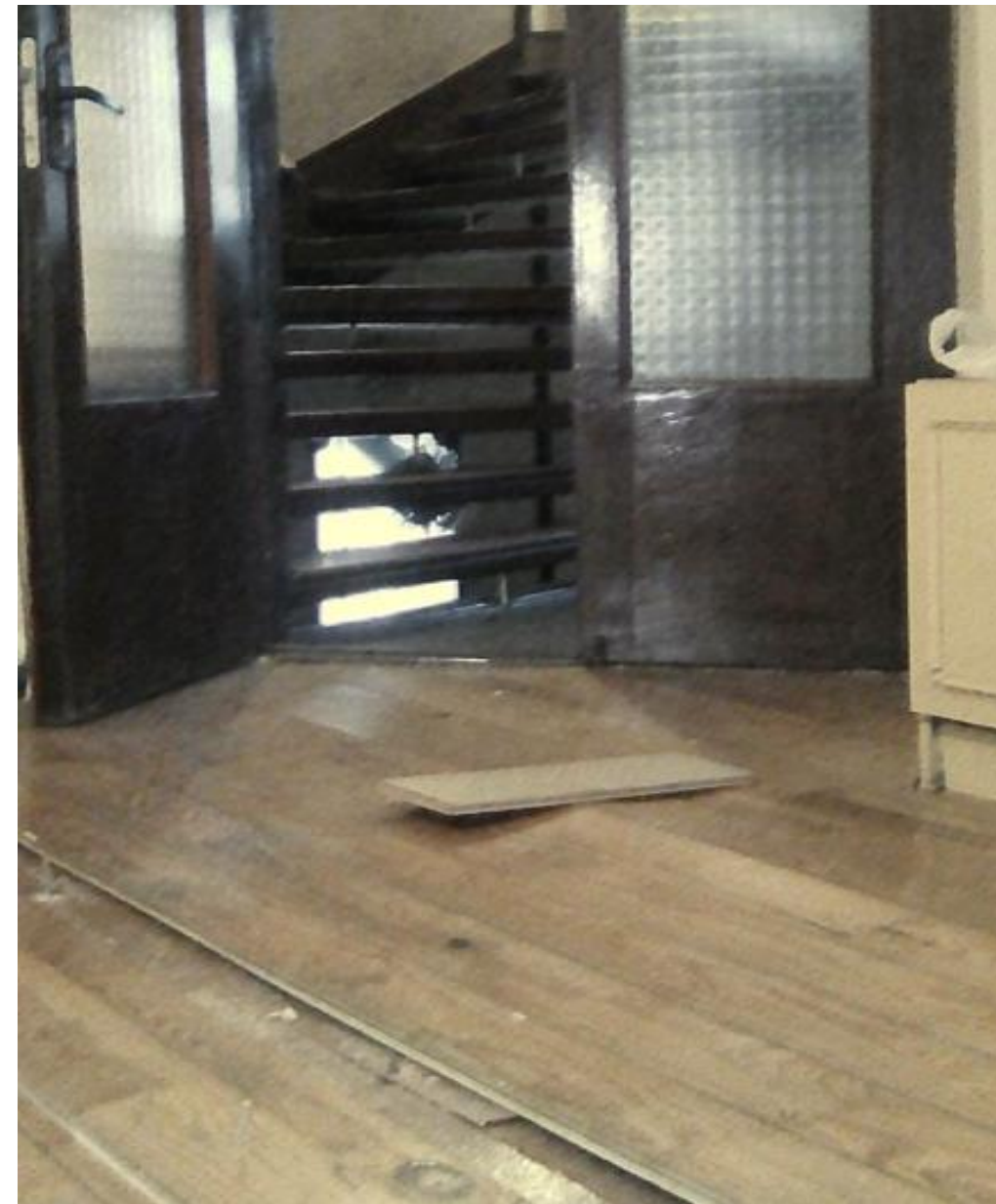
Деформації паркетних дощок при аварії водогону
