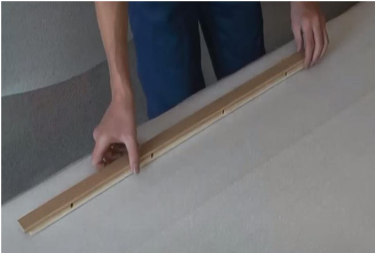
Вкладання паркетних планок з отворами
