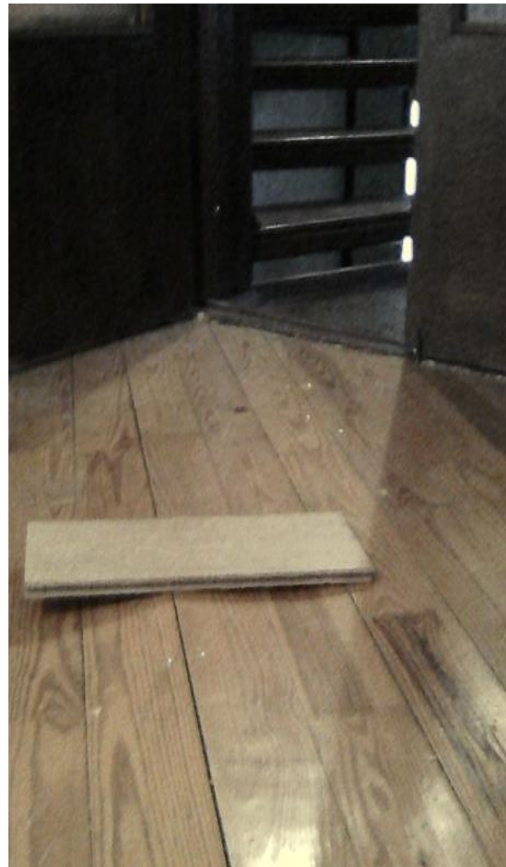
Деформації паркетних дощок при аварії водогону
