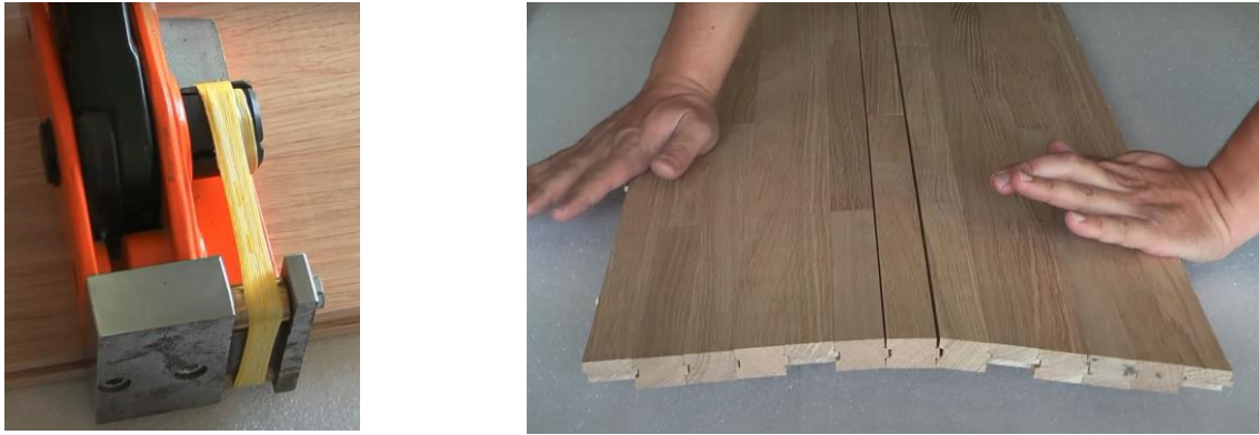
Рис. 2.9 – Натяжний механізм і готове паркетне покриття
