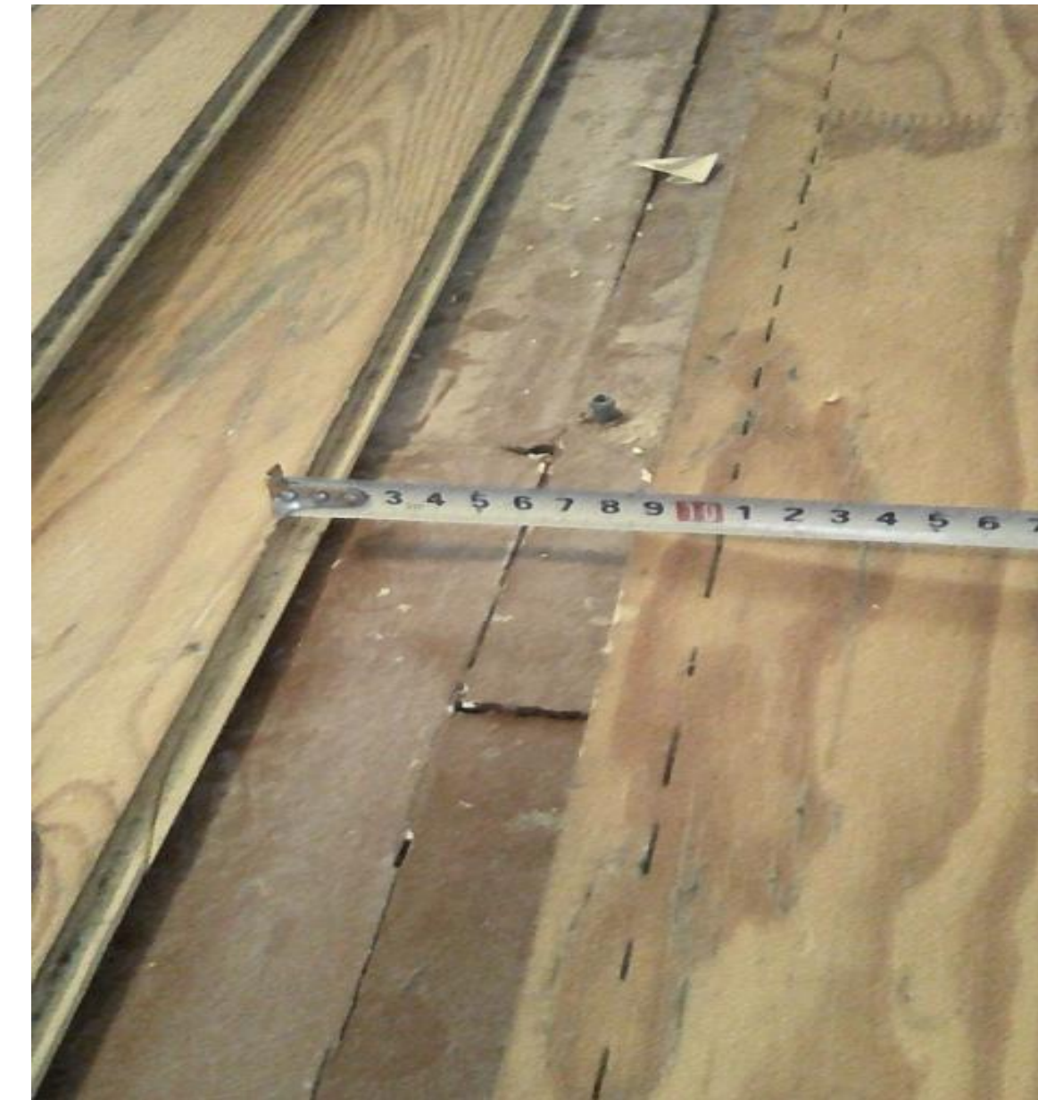
Деформації паркетних дощок при аварії водогону
