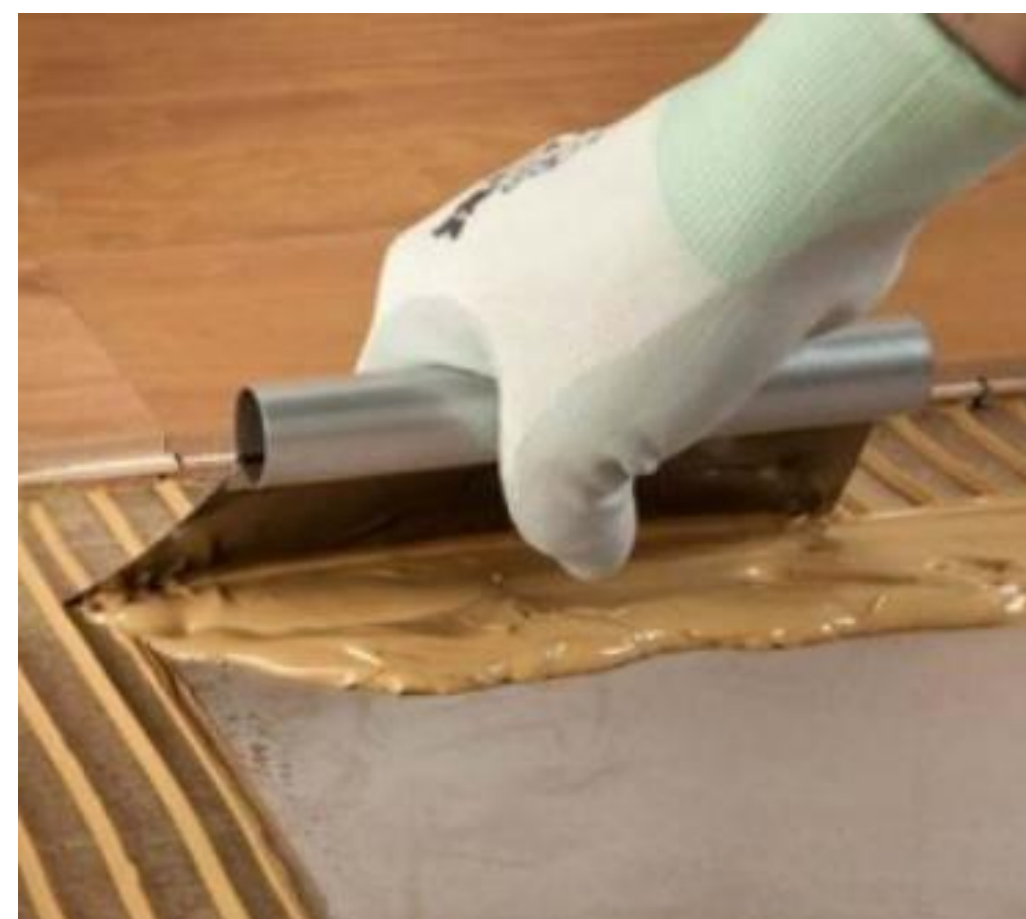
Клейове кріплення паркетних планок
