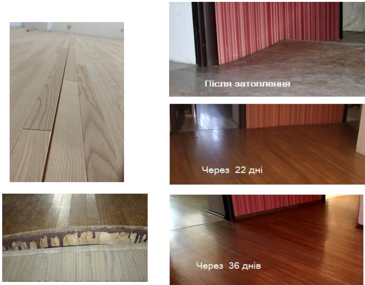
Рис. 3.3 – Деформації паркетних дощок натяжного паркету при затопленні
