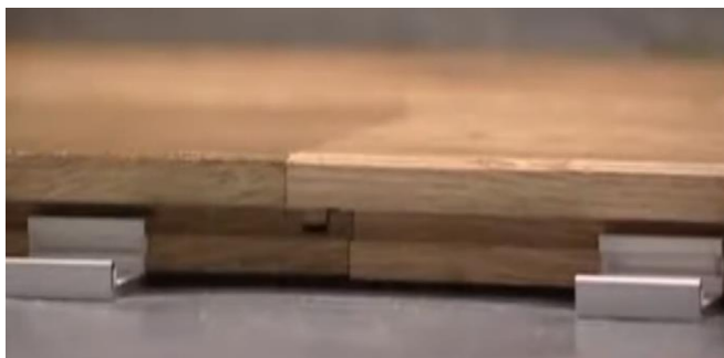
Рис. 2.6 – Використання металевих скоб для кріплення паркетних планок
