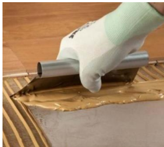
Рис. 2.5 – Клейове кріплення паркетних планок
